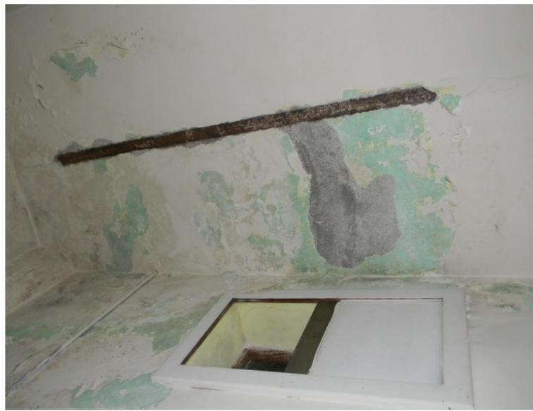
Foto 14: particolare del soffitto in corrispondenza della cucina al piano terra; sono evidenti le infiltrazioni d'acqua dovute alla presenza del bagno al piano superiore
