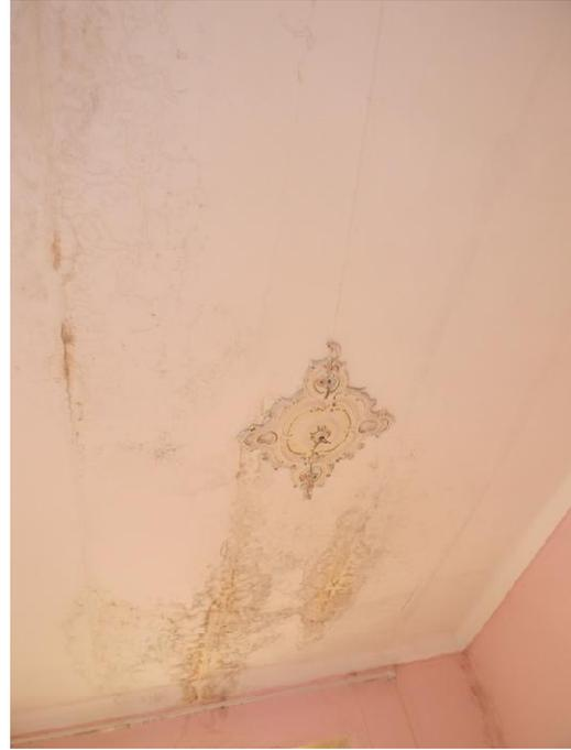
Foto 15: vano al primo piano con affaccio su via Cavour; particolare del soffitto con in evidenza le infiltrazioni d'acqua presenti
