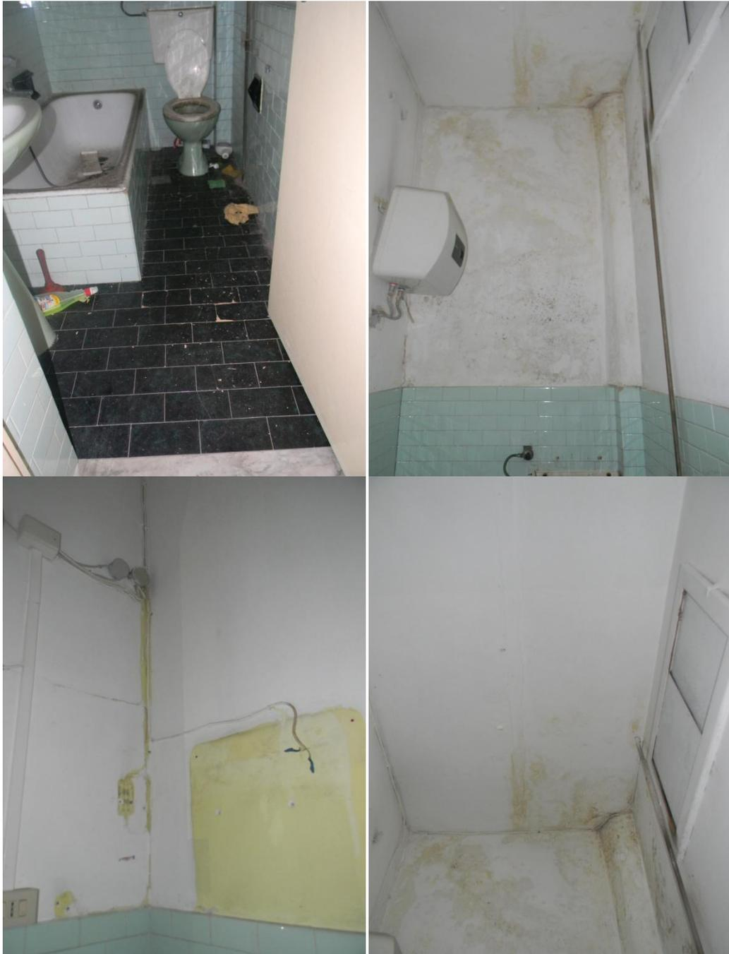
Foto 20: bagno al piano primo; sono evidenti le infiltrazioni d'acqua e l'impianto elettrico non a norma
