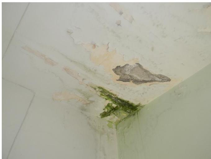
Foto 23: infiltrazioni d'acqua in corrispondenza del soffitto dell'ultimo piano
