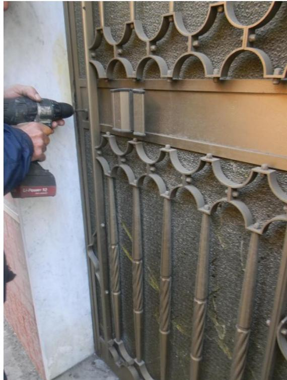
Foto 2: intervento di forzatura della serratura
