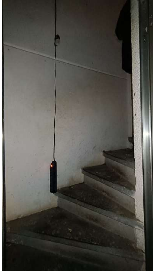
Scala collegamento sub. 6 a sub. 4
