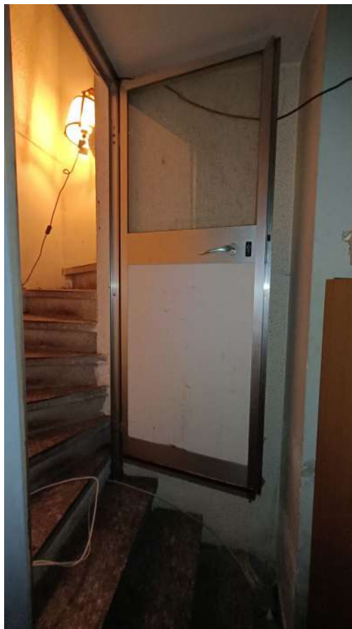
Scala collegamento sub. 6 a sub. 4
