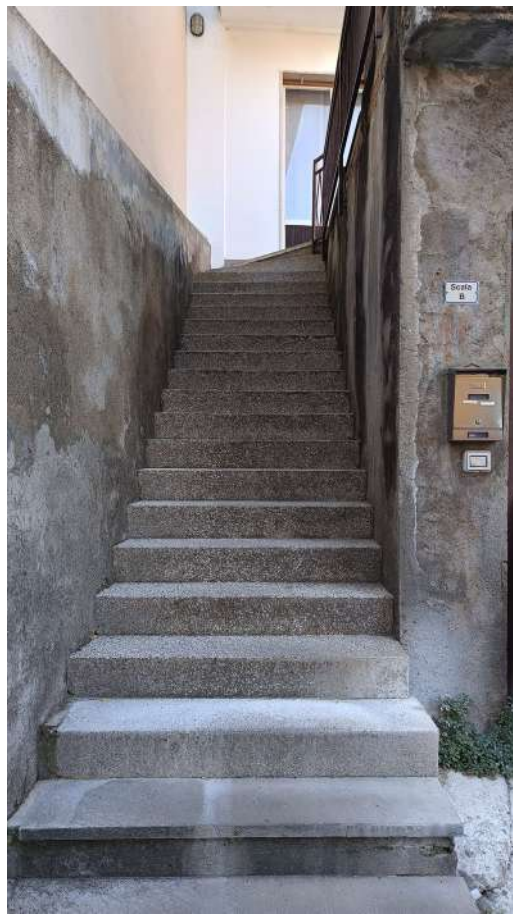
Scala di accesso al Sub. 4
