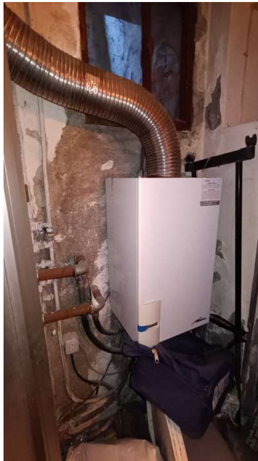
Scala collegamento sub. 6 a sub. 4
