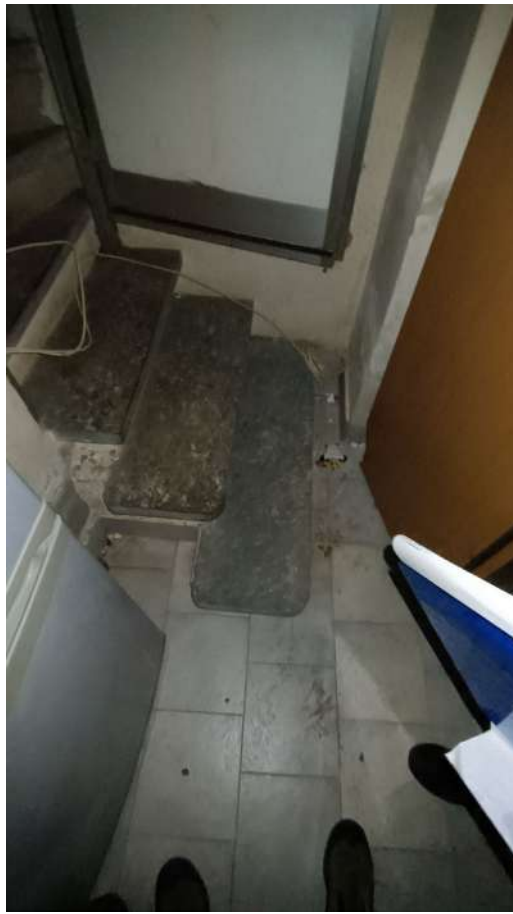
Scala collegamento sub. 6 a sub. 4
