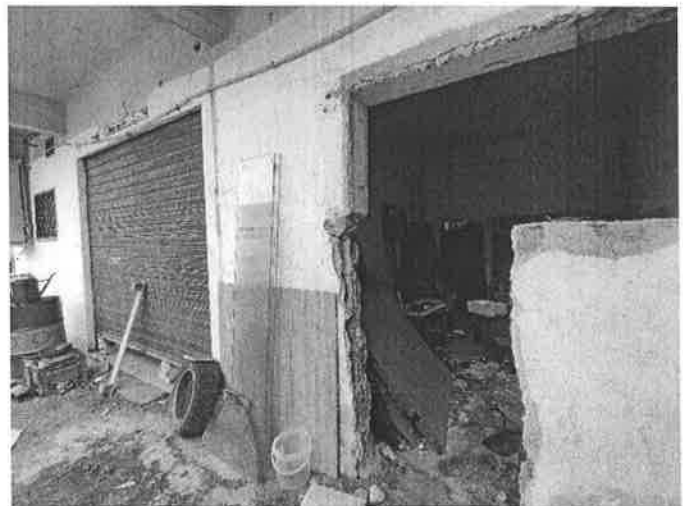
FOTO 5 - VISTA ESTERNA - MAGAZZINO
