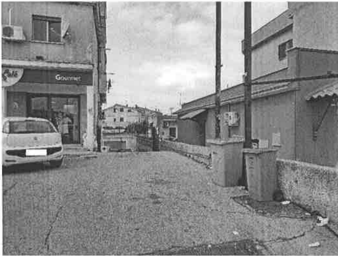
FOTO 1 -VISTA ESTERNO – CORPO DI FABBRICA
