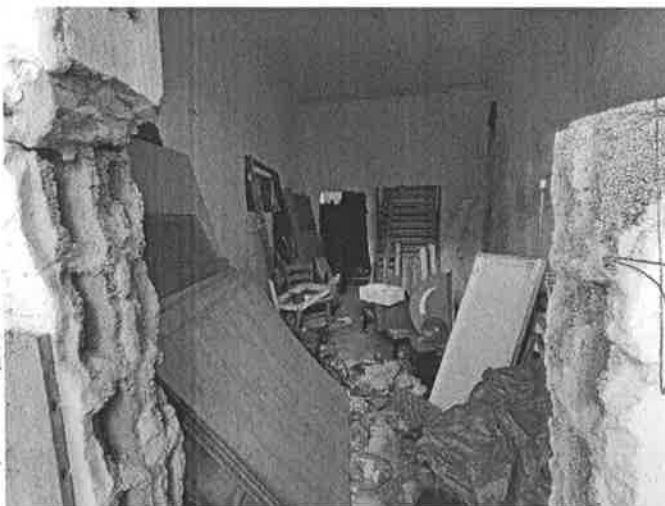
FOTO 6 - VISTA INTERNA MAGAZZINO
