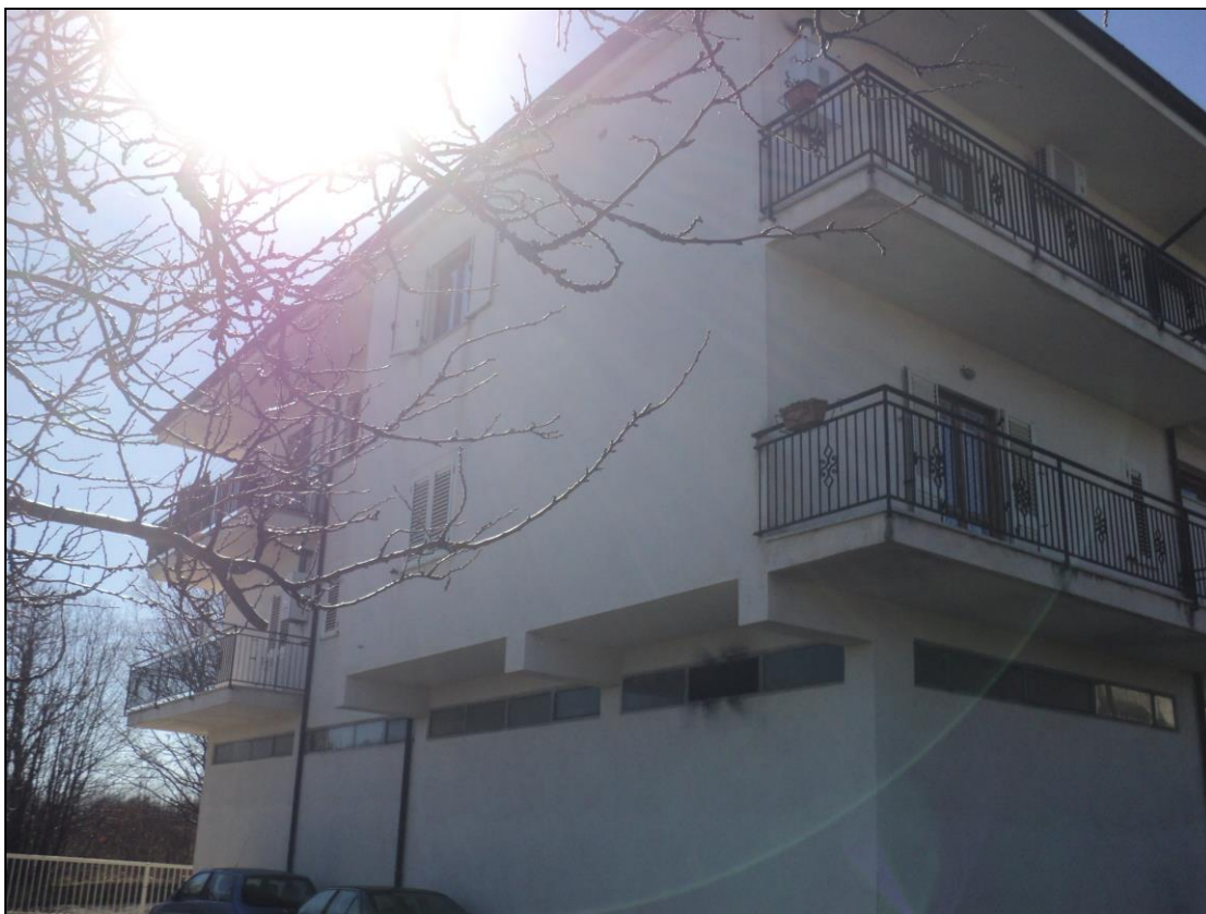
Foto N.3: Prospetto fabbricato lato Nord.
