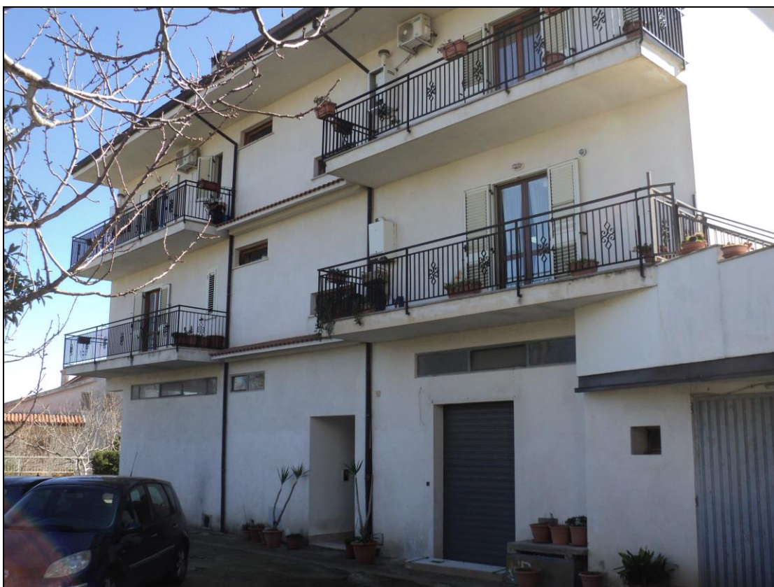
Foto N.4: Prospetto fabbricato lato Est con ingresso.
