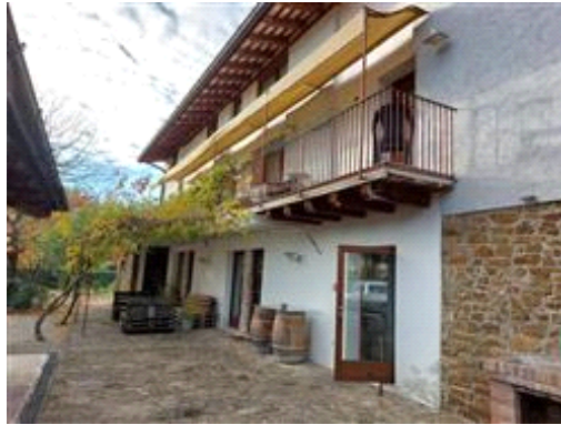
Panoramica edificio lato interno
