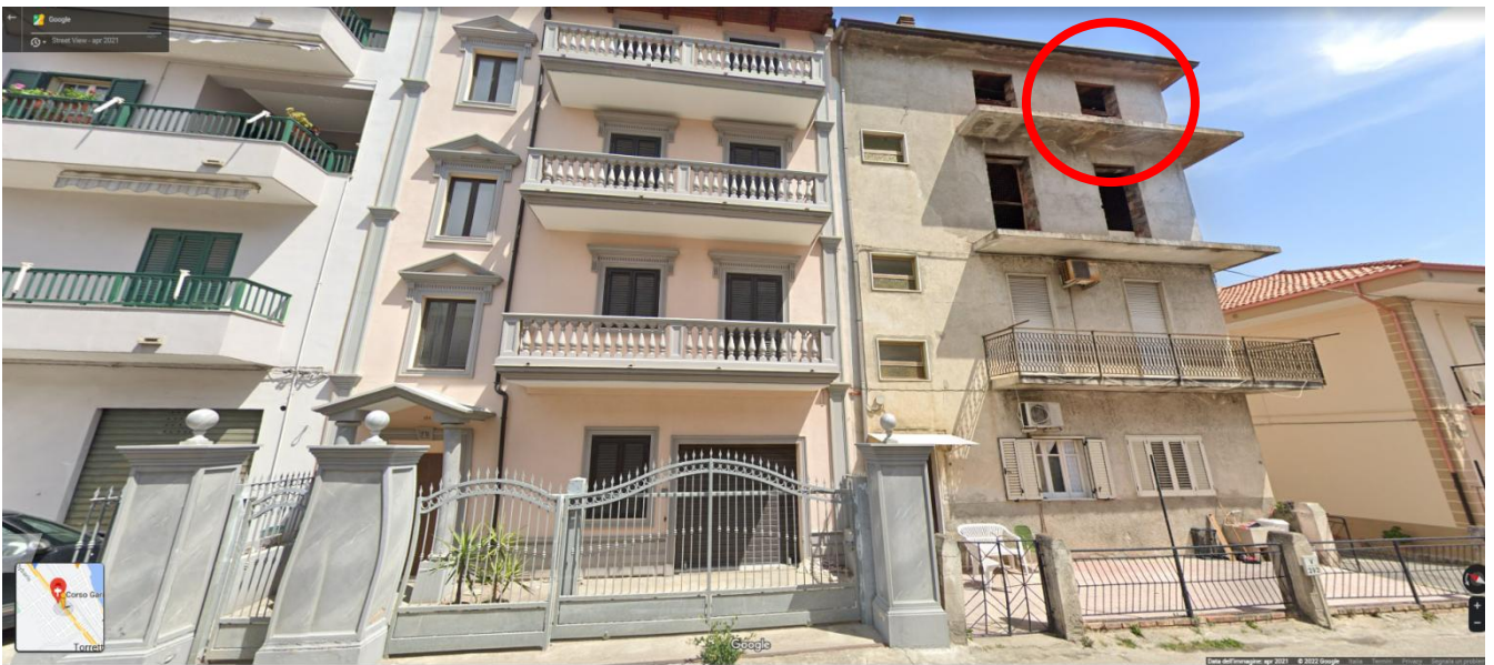
FABBRICATO SITO IN VIA CORSO GIUSEPPE GARIBALDI
