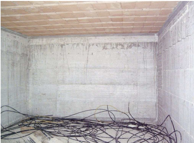
FOTO N° 31 Locale 9 piano 1° Sottostrada
