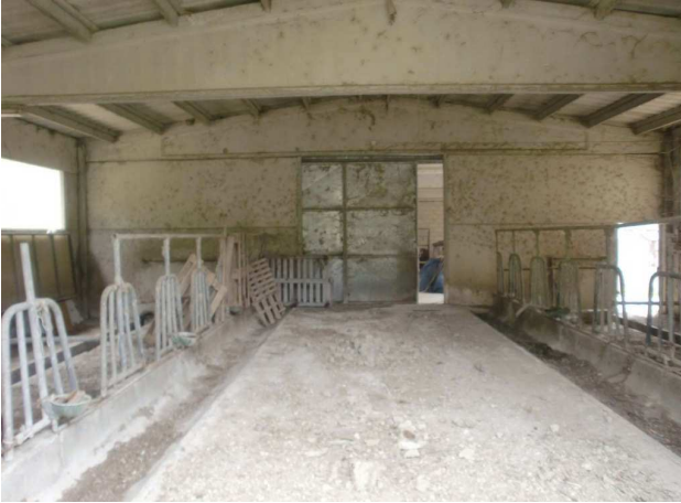
FOTO N° 37 Stalla 1 piano Terra
