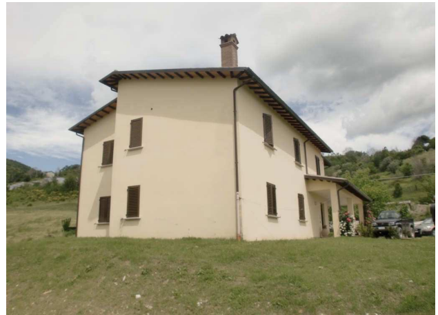
FOTO N° 4 Lato Sud fabbricato di abitazione
