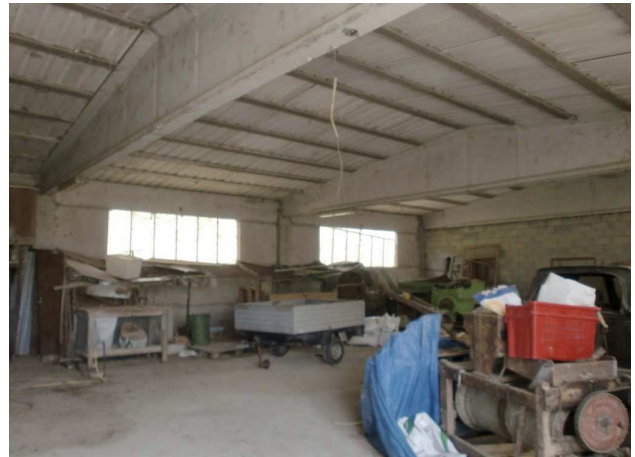
FOTO N° 40 Stalla 2 piano Terra
