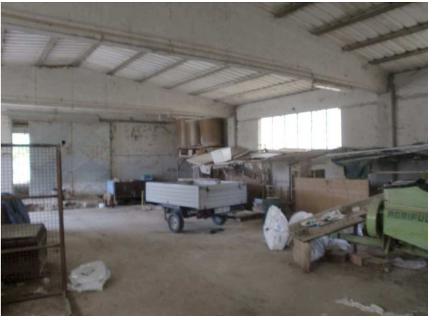
FOTO N° 39 Stalla 2 piano Terra
