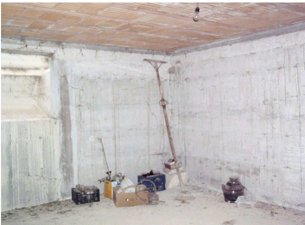
FOTO N° 27 Locale 4 piano 1° Sottostrada
