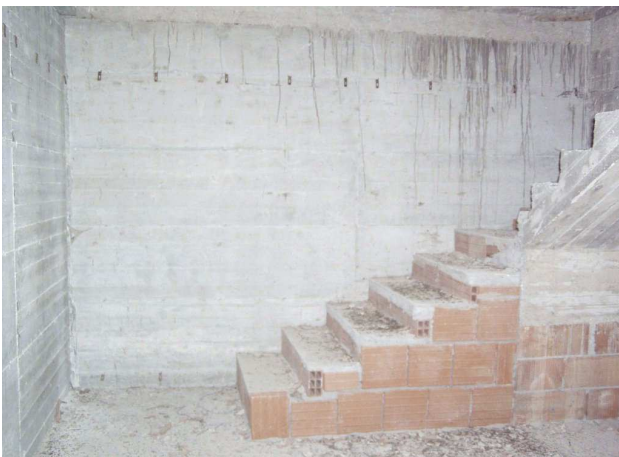
FOTO N° 29 Locale 7 piano 1° Sottostrada
