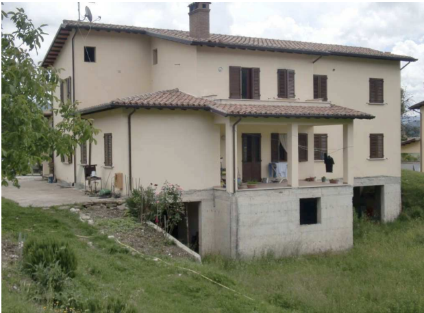
FOTO N° 3 Lato Ovest fabbricato di abitazione
