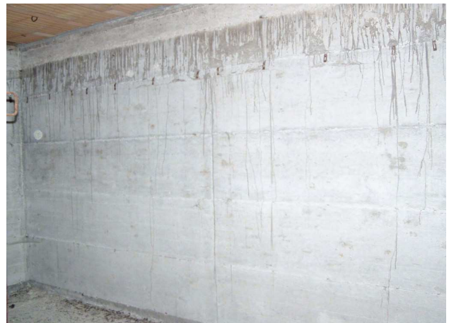
FOTO N° 28 Locale 5 piano 1° Sottostrada
