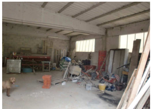
FOTO N° 42 Stalla3 piano Terra
