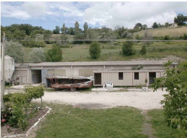
FOTO N° 33 Lato Sud del fabbricato Stalla
