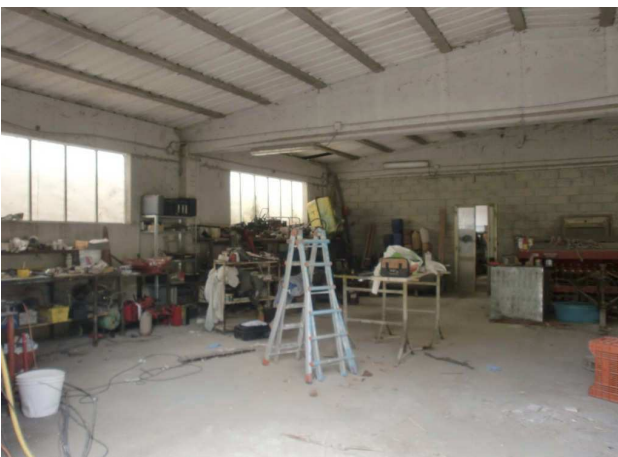
FOTO N° 41 Stalla 3 piano Terra
