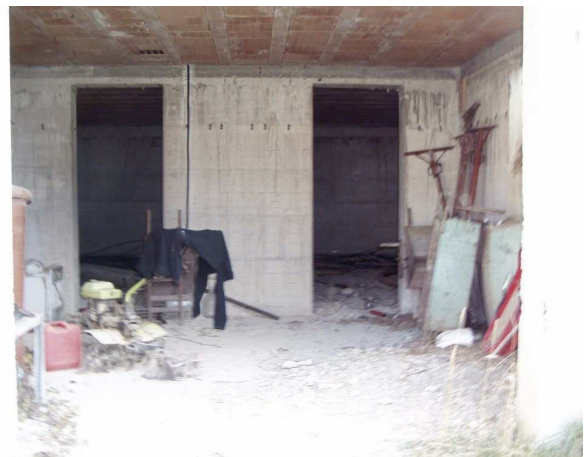
FOTO N° 30 Locale 8 piano 1° Sottostrada
