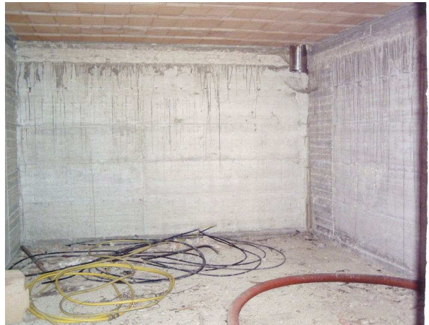
FOTO N° 32 Locale 10 piano 1° Sottostrada
