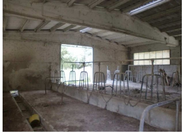
FOTO N° 38 Stalla 1 piano Terra
