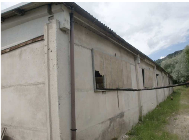
FOTO N° 35 Lato Nord del fabbricato Stalla
