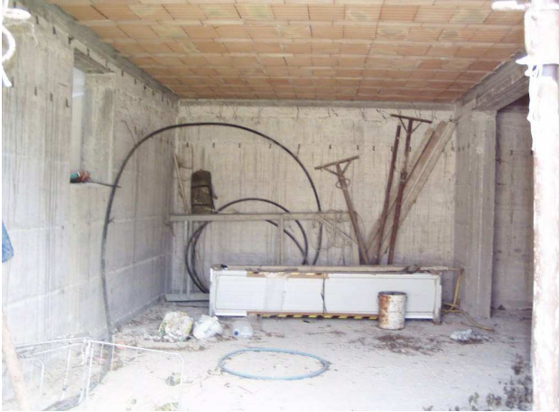
FOTO N° 25 Locale 1 piano 1° Sottostrada
