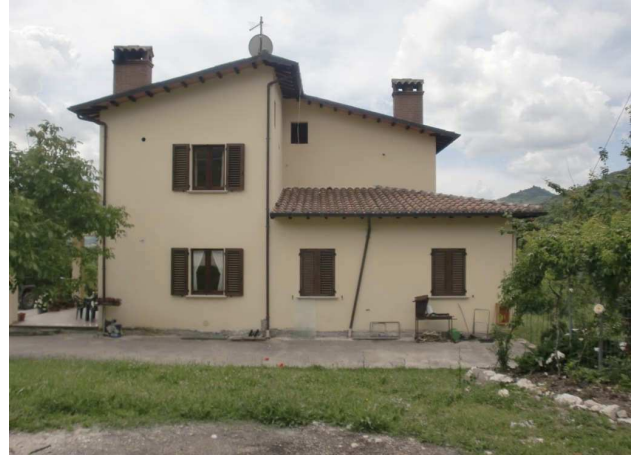
FOTO N° 2 Lato Nord fabbricato di abitazione
