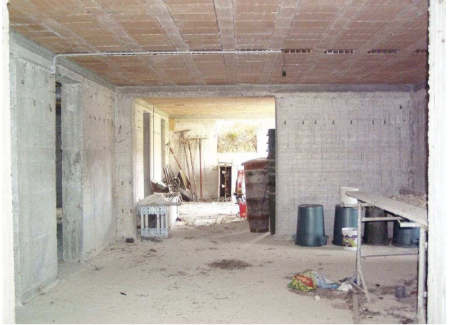
FOTO N° 26 Locale 2 piano 1° Sottostrada
