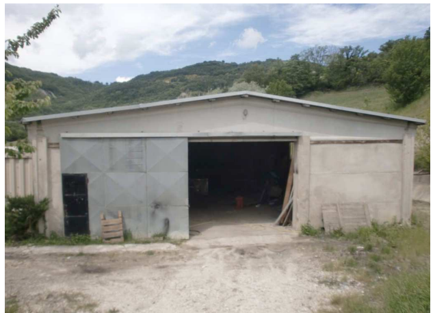
FOTO N° 34 Lato Est del fabbricato Stalla
