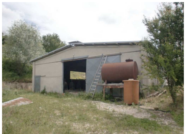
FOTO N° 36 Lato Ovest del fabbricato Stalla
