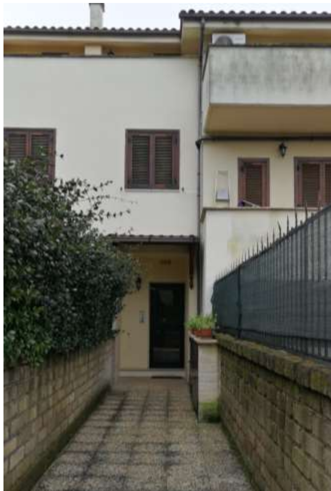
FOTO 02 – Vista Esterna (ingresso condominiale)
