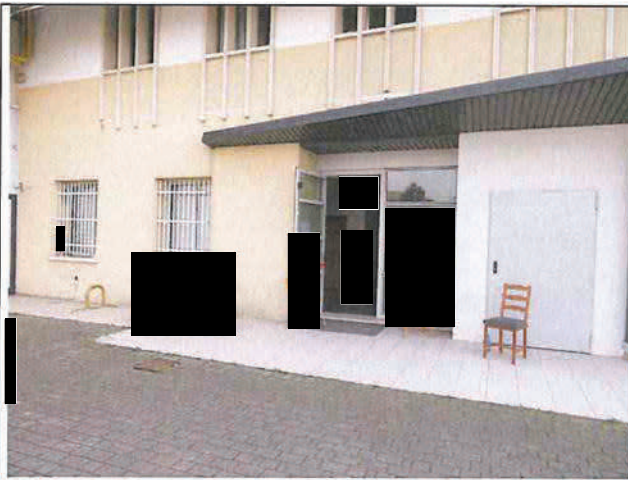
Foto n°109: Ingresso ditta e via di fuga magazzino di vendita
