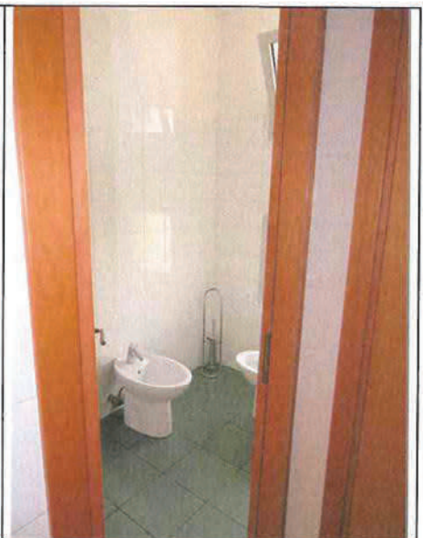
Foto n°127: Servizio con wc
