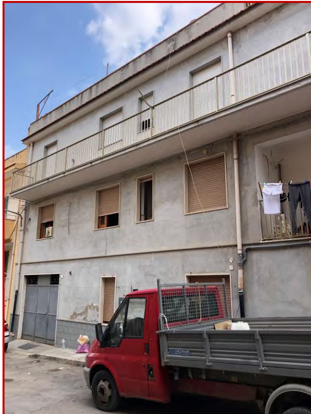
FOTO 2 – prospetto su Via Enna in corrispondenza del civico 15
