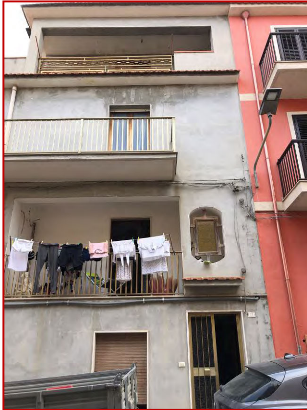
FOTO 1 – prospetto su Via Enna in corrispondenza del civico 17
