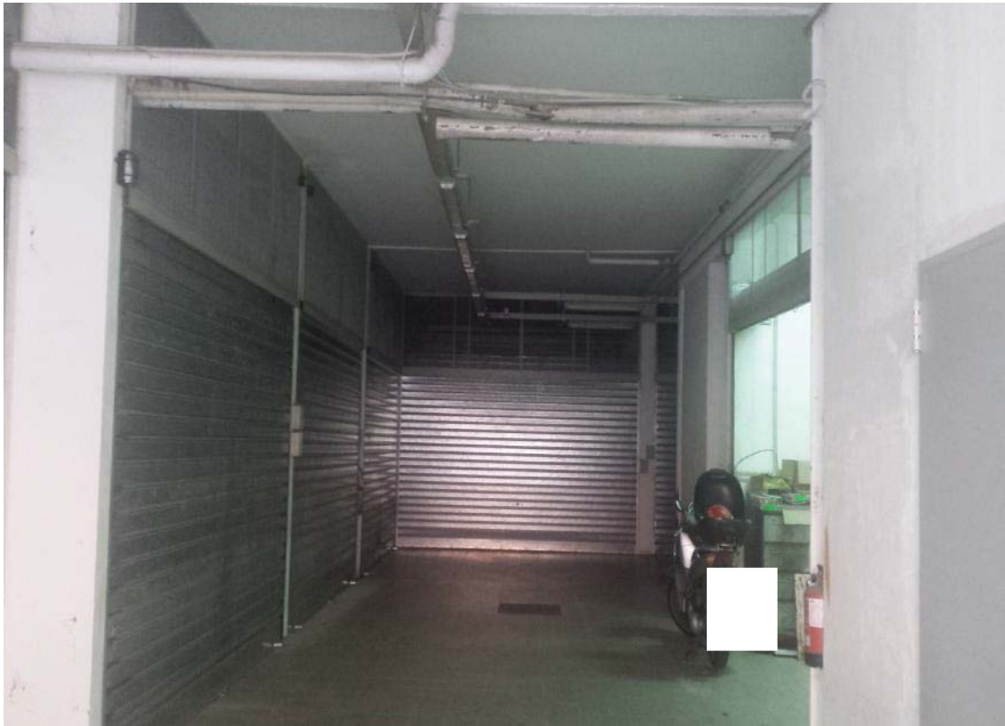
Foto n° 3 – Area d'accesso ai box
