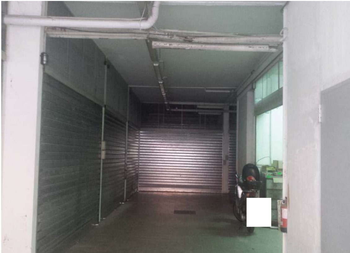
Foto n° 3 – Area d'accesso ai box
