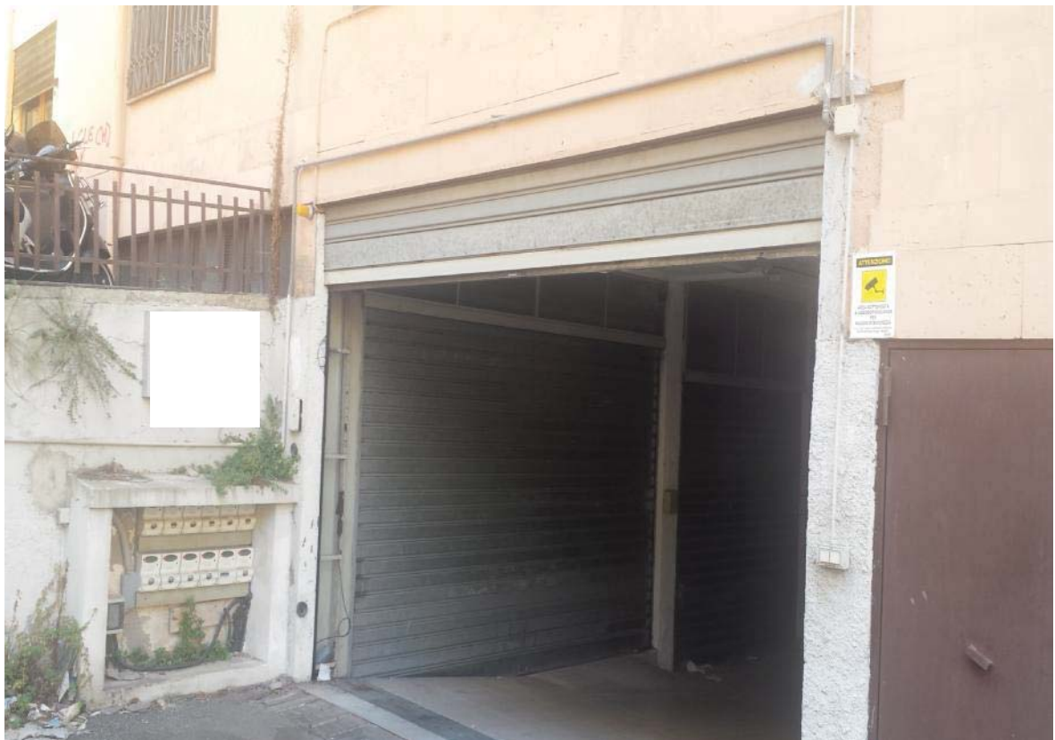
Foto n° 2 – Portone d'ingresso del piano sottoterra
