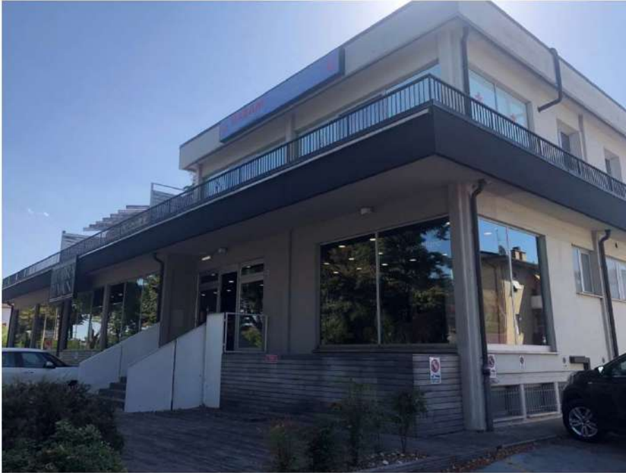
Foto 1 - Prospetto Nord-Est – Viale Roma
