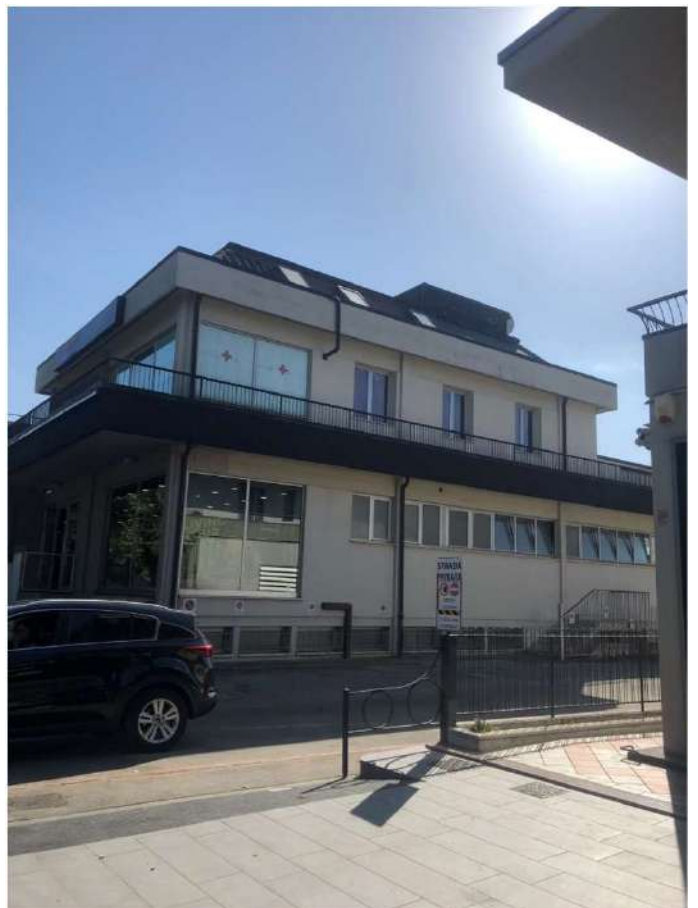
Foto 2 - Prospetto Nord-Ovest – Viale Roma
