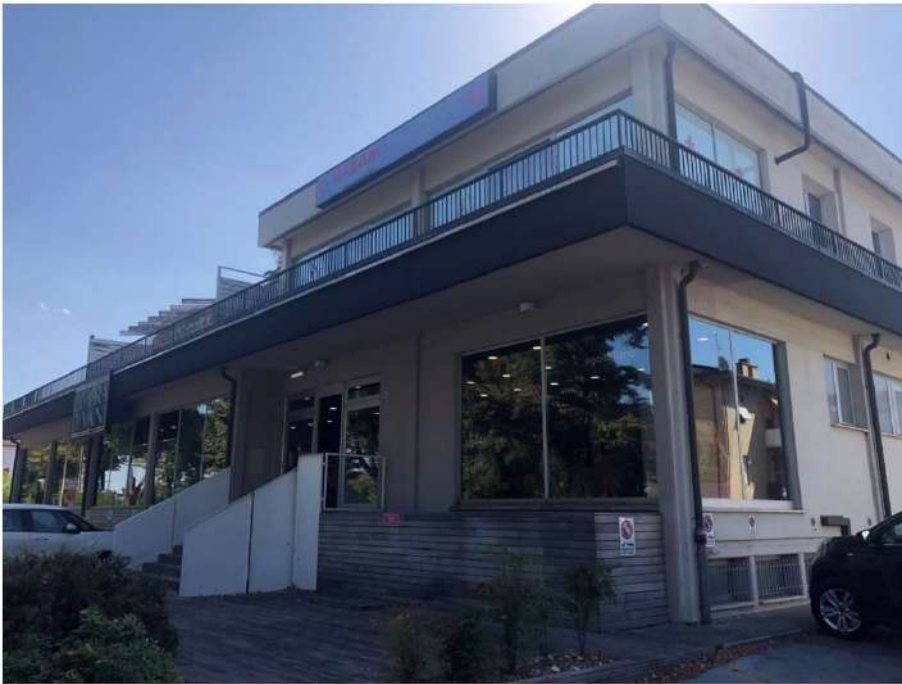
Foto 1 - Prospetto Nord-Est – Viale Roma
