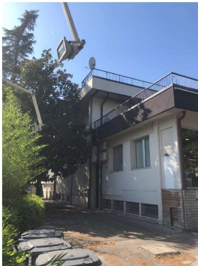
Foto 4 - Prospetto Sud-Ovest – Viale Roma
