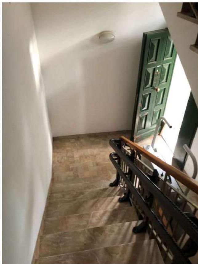
Foto 6 – vano scala comune
