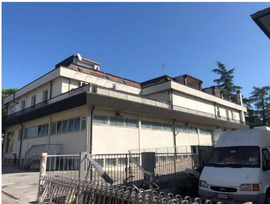
Foto 3 - Prospetto Sud-Ovest – Viale Roma
