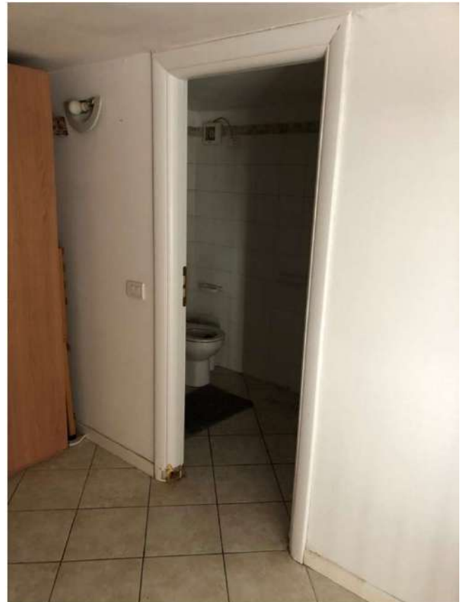
Foto 14 – accesso alla lavanderia
