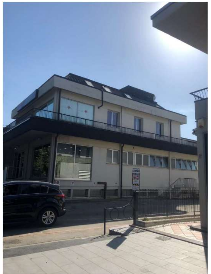
Foto 2 - Prospetto Nord-Ovest – Viale Roma
