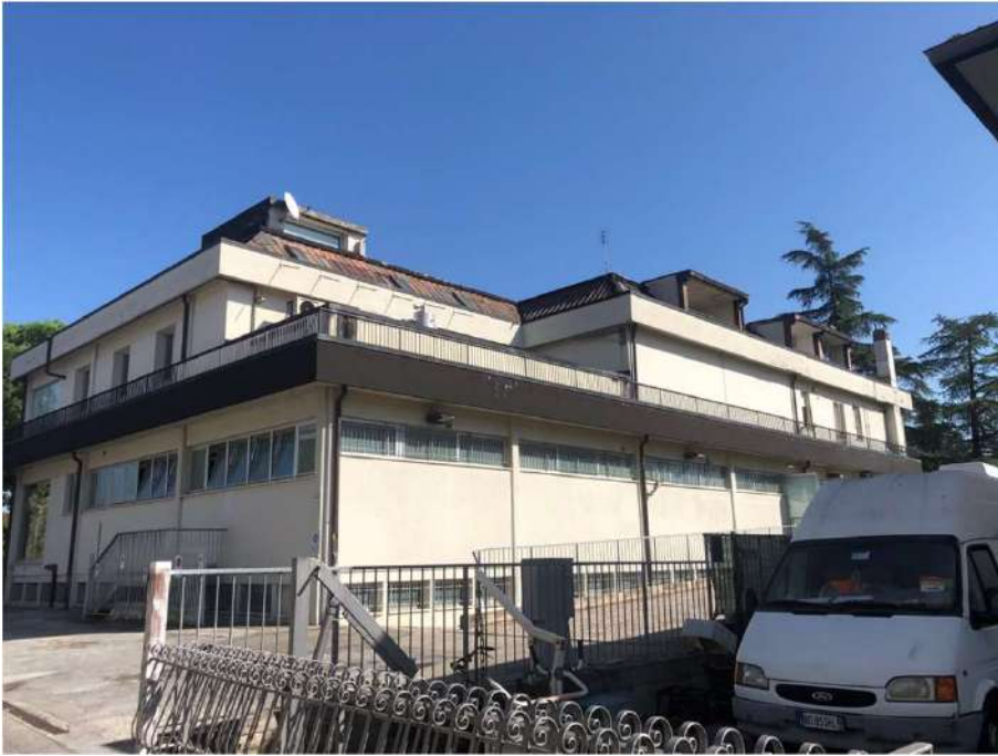
Foto 3 - Prospetto Sud-Ovest – Viale Roma
