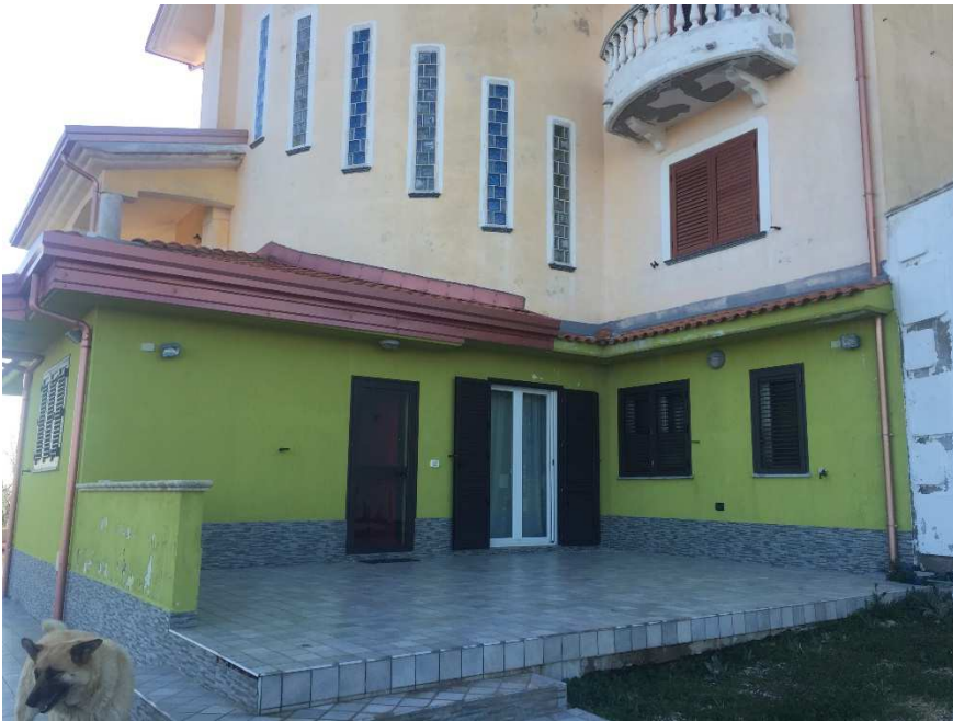
Foto 5 – Veduta esterna ingresso piano seminterrato
