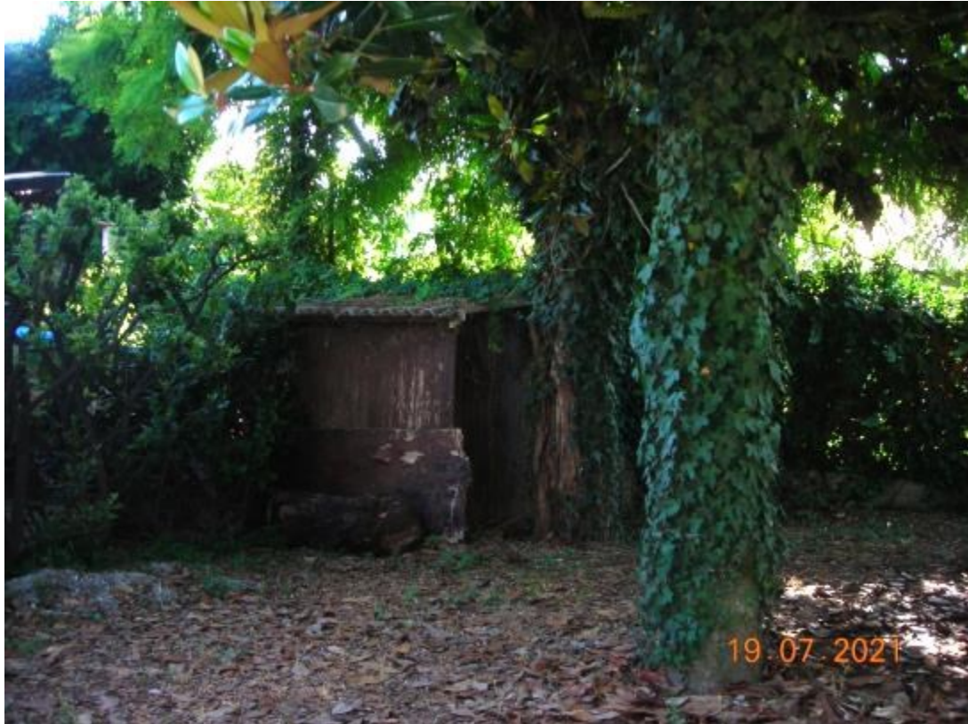
BARACCA DA RIMUOVERE
