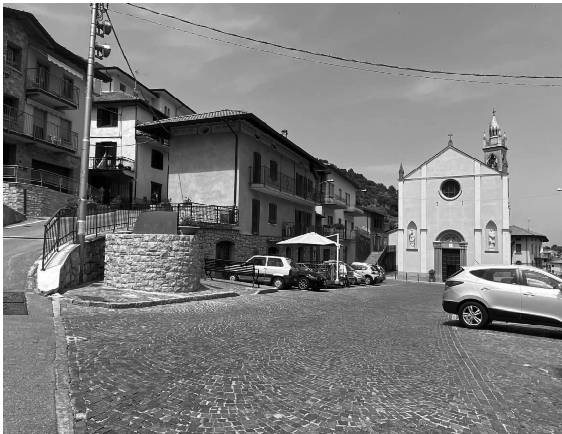
2 Vista del fabbricato e della piazza Parroci Ongaro
