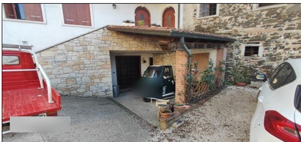
Portico lato nord-ovest – ingresso esterno al piano seminterrato
