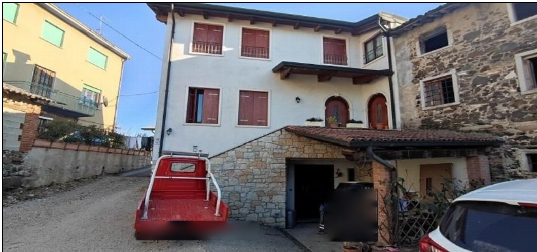
Vista esterna dell'abitazione lato nord-ovest - accesso dalla corte comune interna
