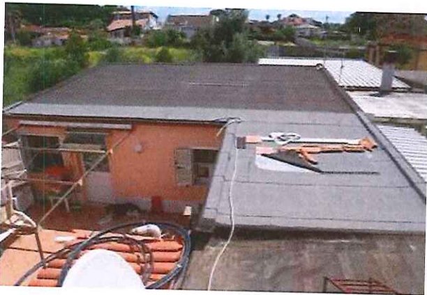
Foto 06 – Lotto 1 – Vista dall'alto fabbricato
