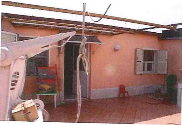
Foto 08 – Lotto 1 – Prospetto porta ingresso
