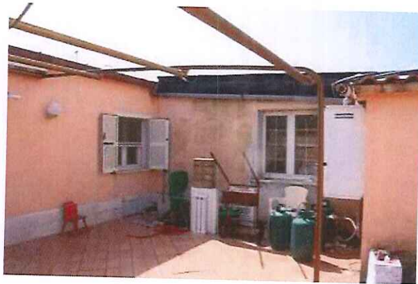
Foto 09 – Lotto 1 – Prospetto angolo nord-ovest
