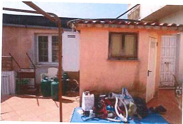
Foto 10 – Lotto 1 – Vista locale tecnico
