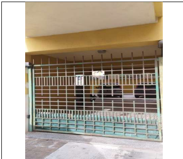
Foto 4. Vista del cancello che consente l'accesso al parcheggio sito all'interno della corte del fabbricato, al piano terra
