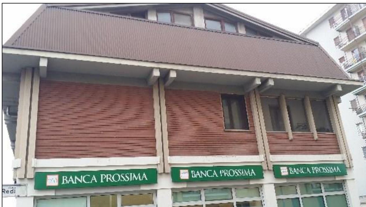
Figura 5 – immagine esterna dell'immobile di cui il magazzino è parte
