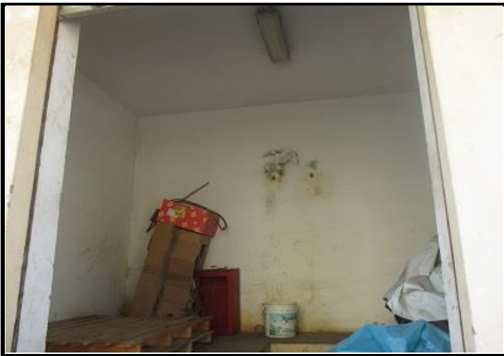
Foto n°27 - Deposito carburanti Interno
