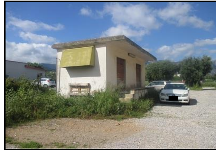
Foto n°26 - Deposito carburanti Esterni
