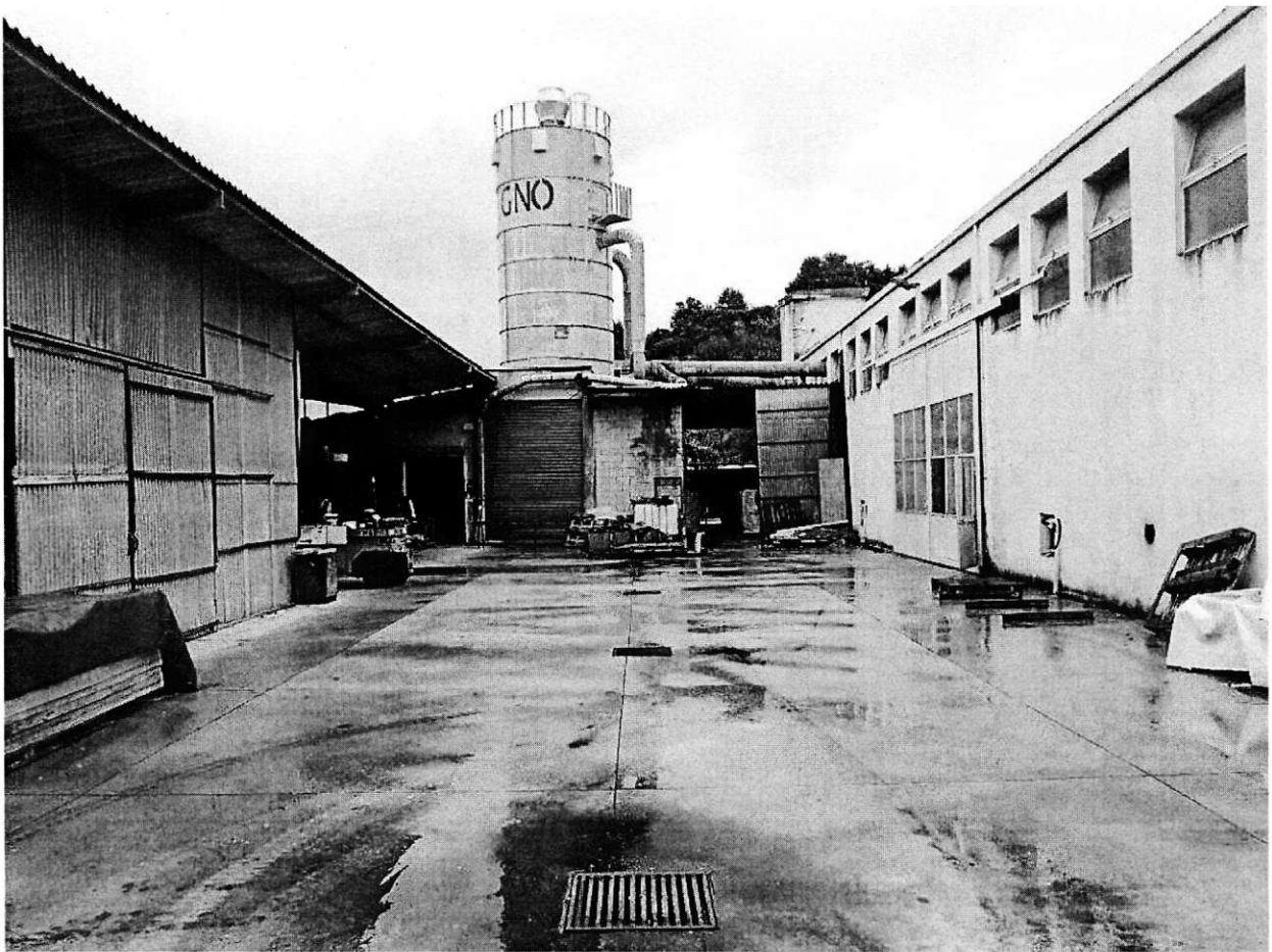
foto 1 - vista della zona di manovra e di parcheggio interna
