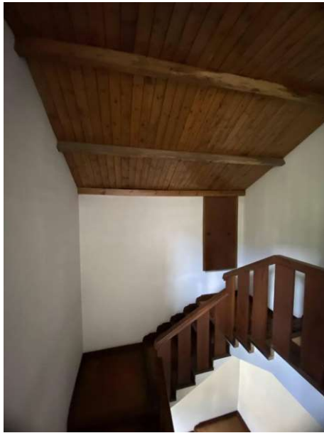
99. Vano scala e ripostiglio
