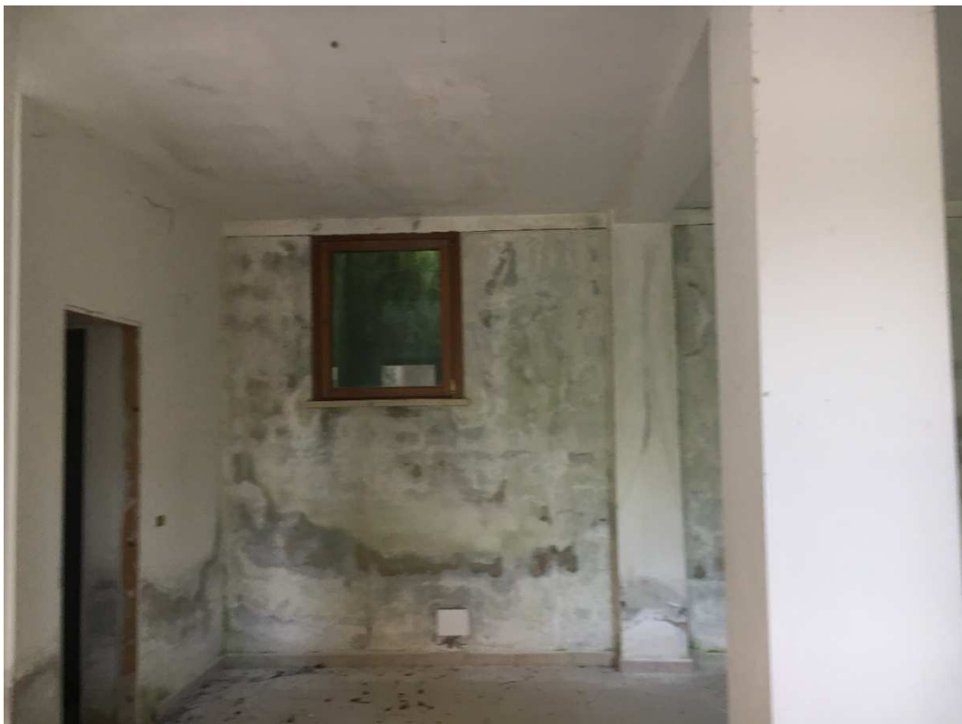
Interno locali piano terra
