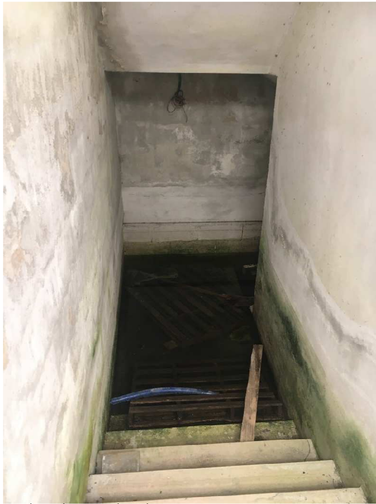
Scala per scendere al piano interrato
