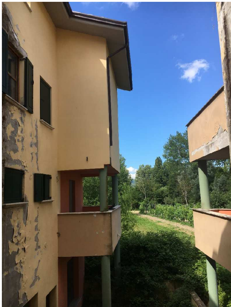
Prospetto esterno piano primo
