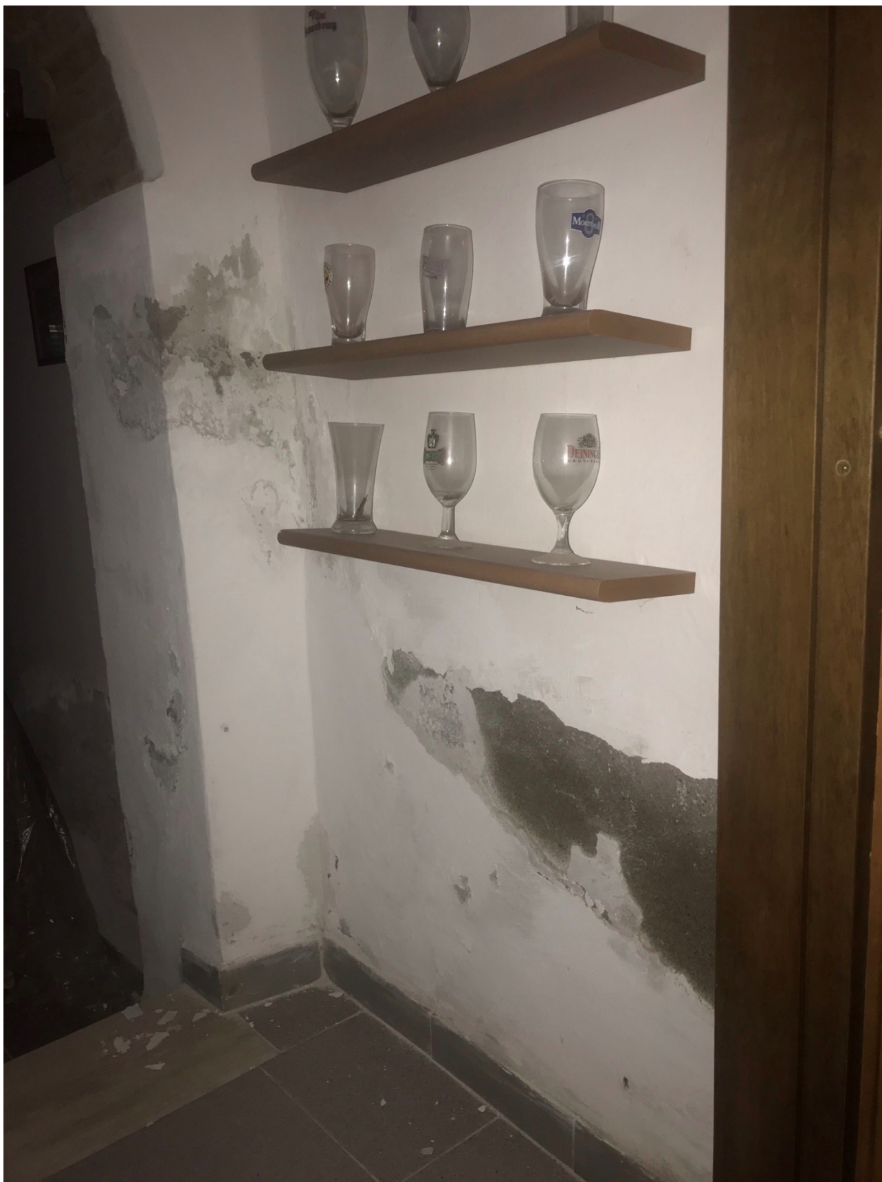
Vista disimpegno piano seminterrato e accesso alla zona giorno
