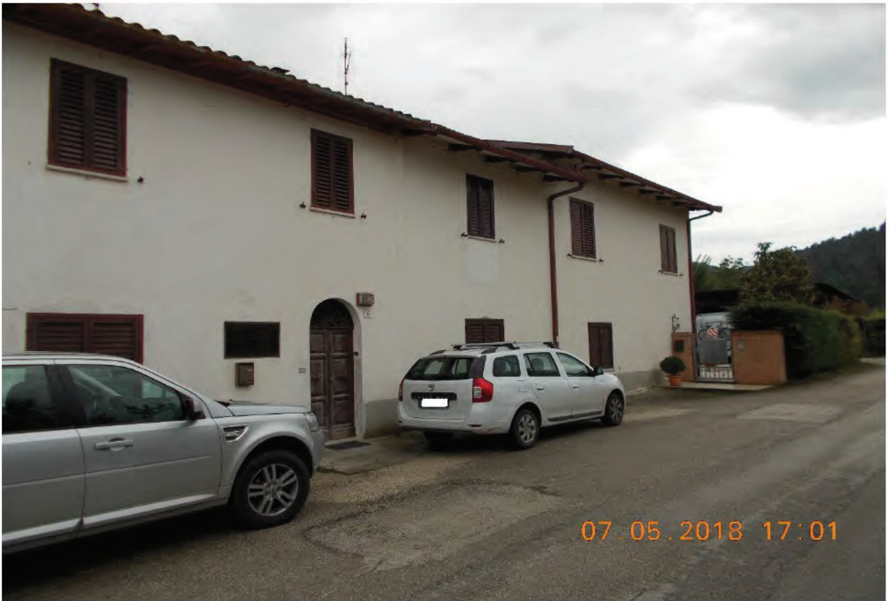
FOTO 1 – ESTERNO FABBRICATO LATO STRADA
