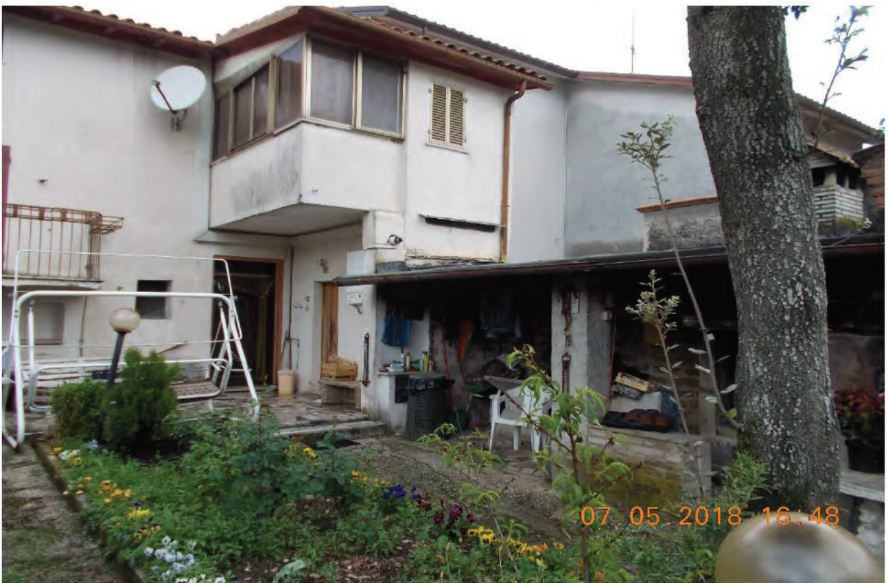
FOTO 2 – ESTERNO FABBRICATO LATO CORTE
