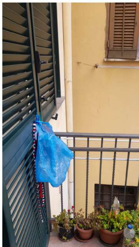
Foto 11 – Vista balcone (P1), del fabbricato oggetto di esecuzione
