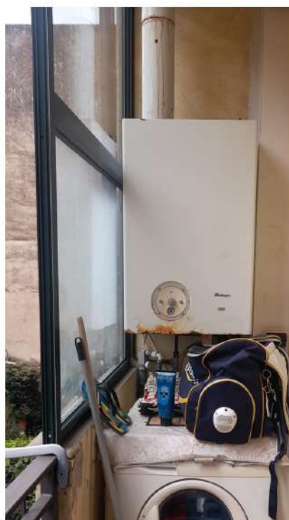
Foto 12 – Altra vista balcone/caldaia (P1), del fabbricato oggetto di esecuzione
