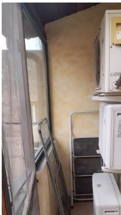
Foto 23 – Altra Vista balcone (P2), del fabbricato oggetto di esecuzione
