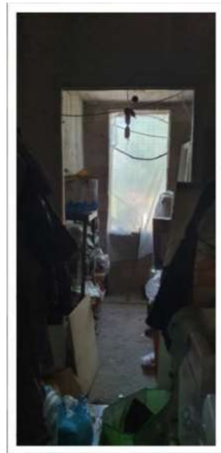
Foto n. 7 – Locale realizzato in assenza di Titolo Abilitativo
