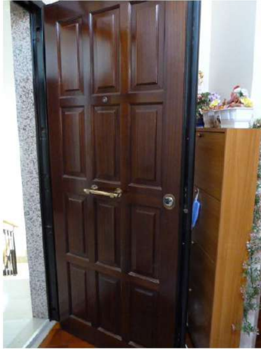
Foto n. 3 – Il portoncino blindato d'ingresso, cui durante l'accesso forzoso è stata sostituita la serratura con un modello di sicurezza a cilindro europeo di qualità medio/alta.
