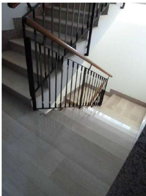
Foto n. 2 – la scala condominiale, munita di ascensore.
