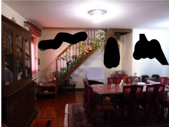
Foto n. 5 – La scala cieca nel soggiorno, a seguito di frazionamento dal piano superiore.
