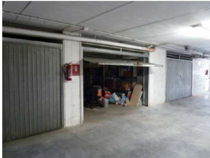
Foto n. 12 – Il box auto al piano interrato, prospiciente l'area di manovra condominiale.
