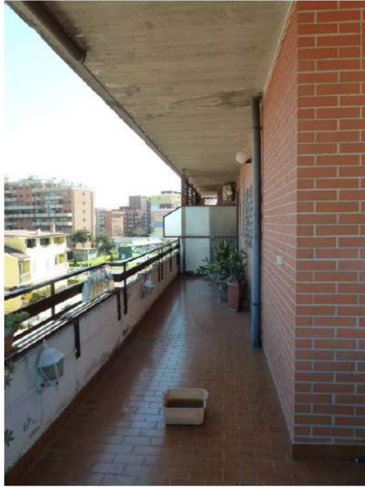
Foto n. 9 – Altro lato della terrazza.
