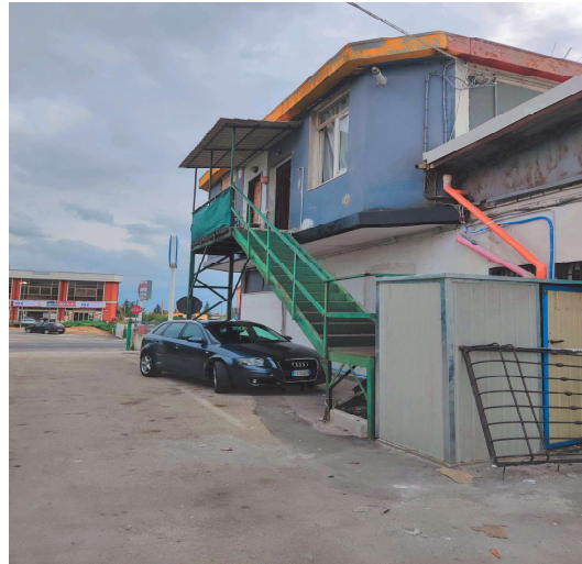
Foto 2: vista lato del piazzale esterno
