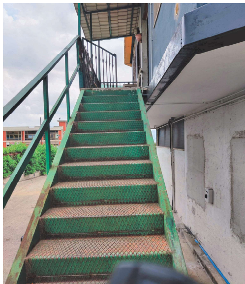
Foto 3: vista scala di accesso
