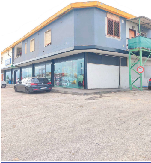
Foto 1: vista lato accesso di via Tiburtina Valeria
