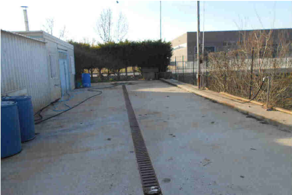
vista area lavaggio automezzi con manufatti prefabbricati
