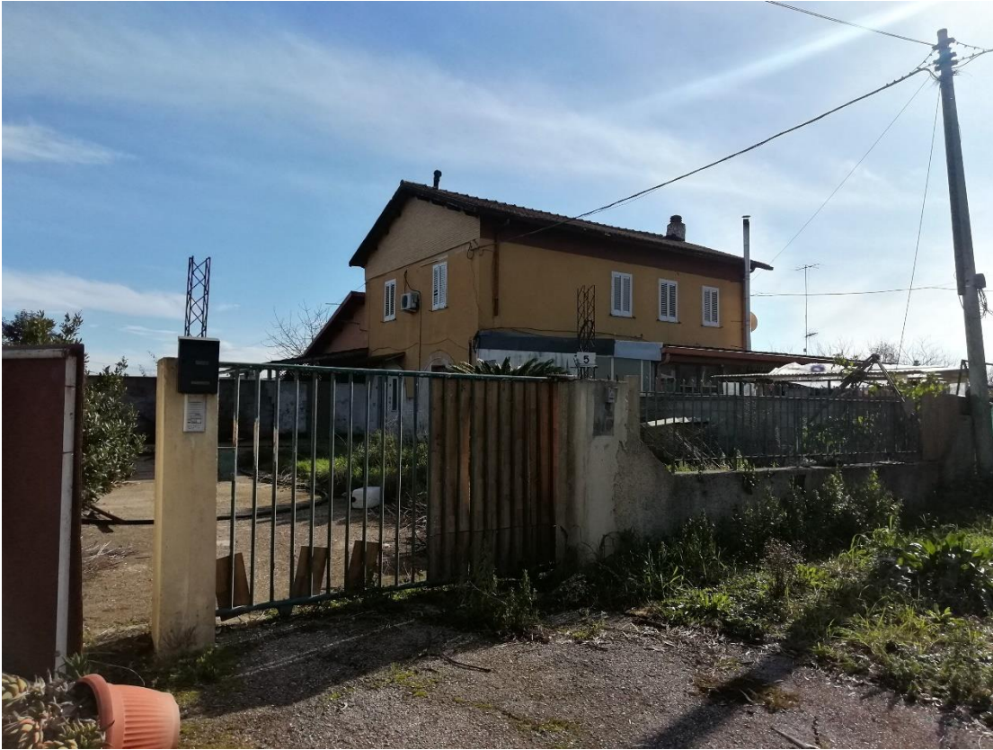
Foto 1 Ingresso dalla via del Valloncello n 5
