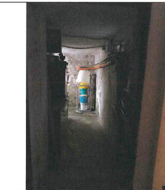
Foto n°33: Cavedio a sud-ovest
