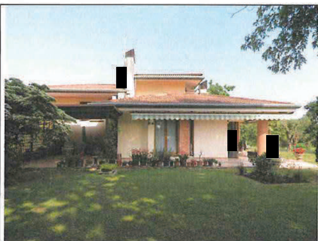
Foto n°13: Facciata ovest con gazebo
