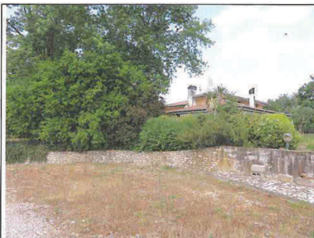
Foto n°11: percorso carrabile ad ovest
