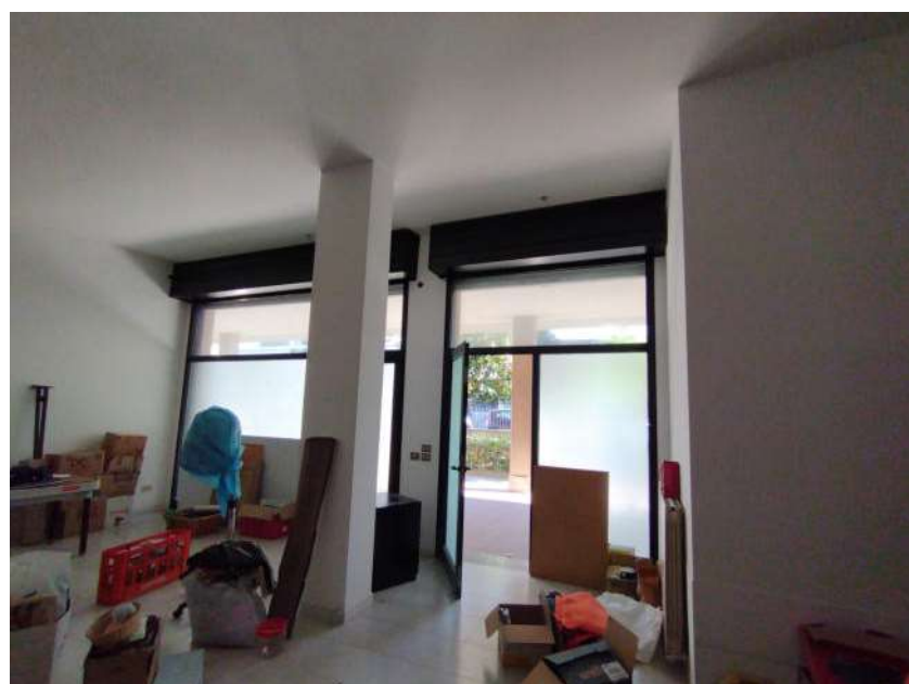
Interno sub 43 - Lotto 2
