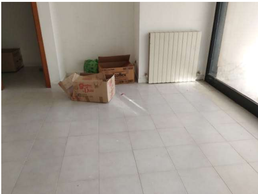
Interno sub 9 - Lotto 1
