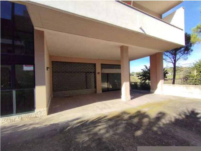
Ingresso e portico sub 6 – Lotto 3
