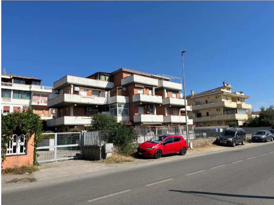
Foto 2 _ Vista esterna _ della palazzina
