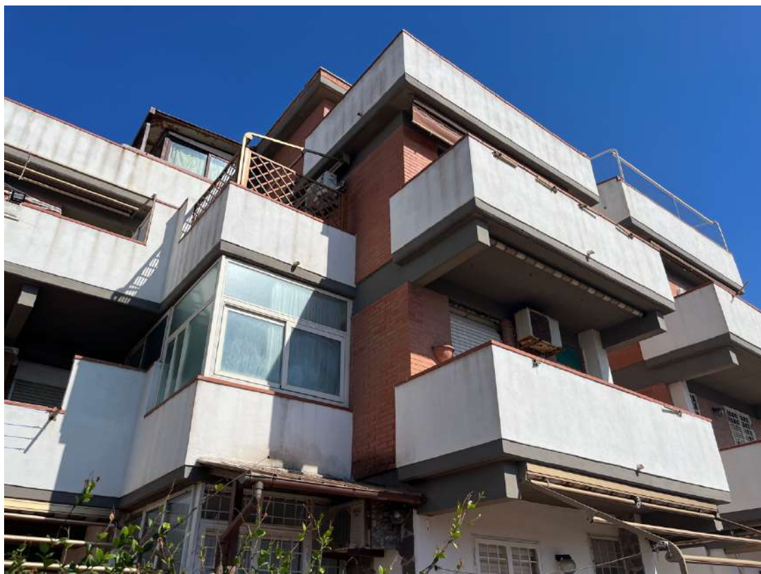
Foto 4 _ Vista esterna _ Appartamento int 7 Piano 1
