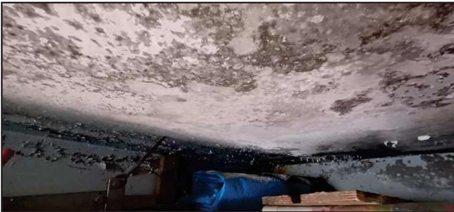
**Fotografia 13 – LOTTO 1 – Infiorescenze e muffe presenti su soffitto causate da infiltrazioni di acqua dalla copertura.**
