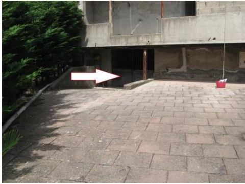
Foto 23 accesso al deposito al piano seminterrato
