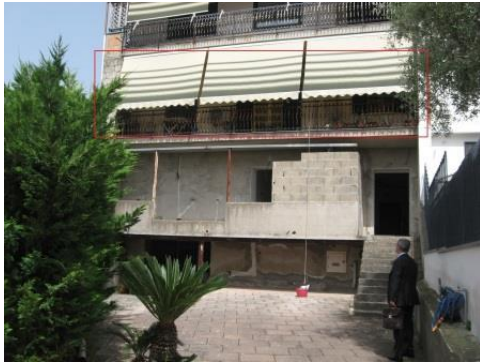
Foto 3 facciata ovest del abbricato
