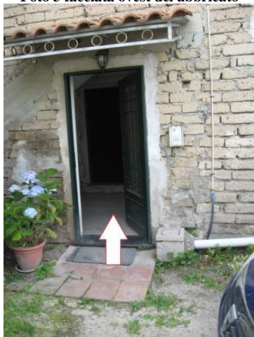
Foto 5 accesso al vano scala dal cortile comune
