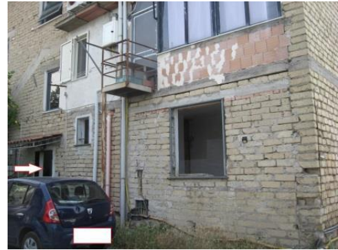
Foto 4 facciata est del fabbricato
