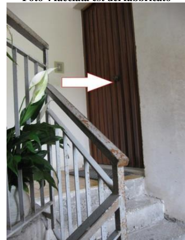
Foto 6 accesso dal vano scala
