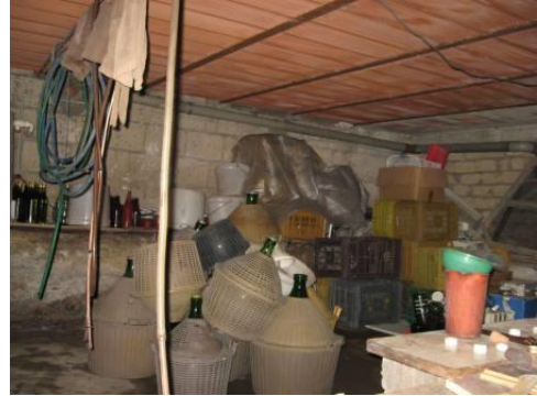
Foto 26 vano 3 del deposito al piano seminterrato
