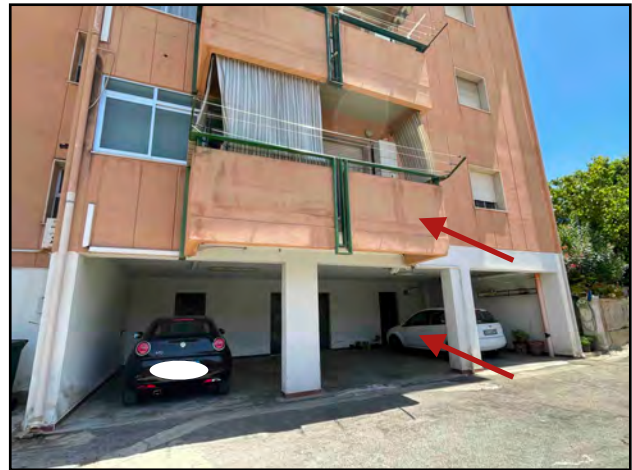
Appartamento e sottostante cantina
