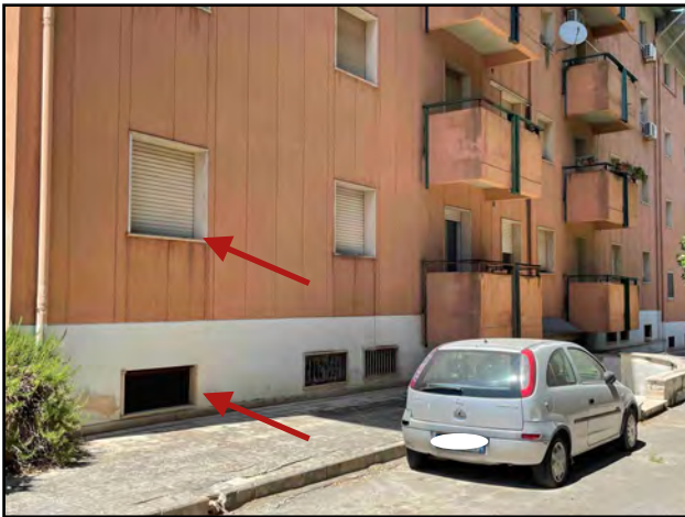
Appartamento e sottostante cantina
