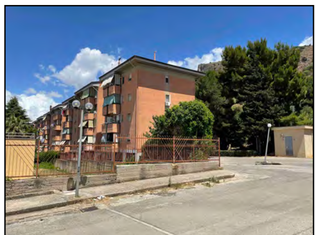
Testata sud-ovest del fabbricato
