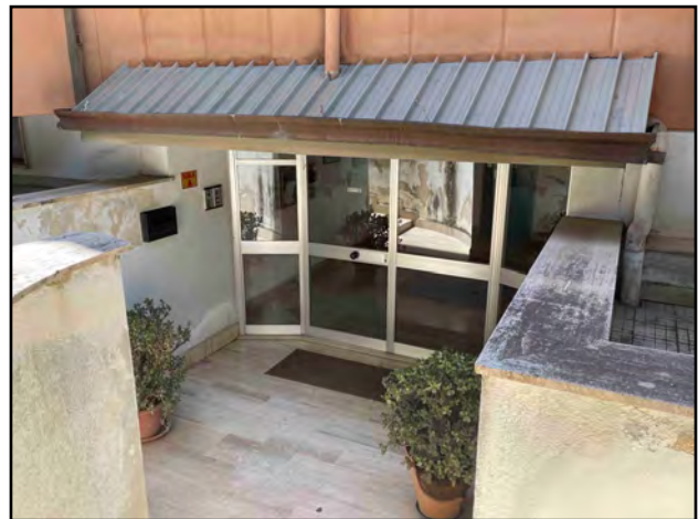
Accesso al corpo scala A
