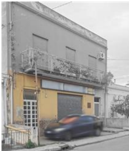
Prospetto anteriore su via Policastrelli
