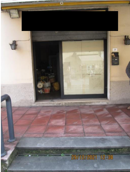
Foto 4 Ingresso su via del Porcellino
