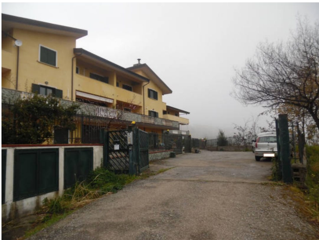
Foto 1: cancello d'ingresso al fabbricato
