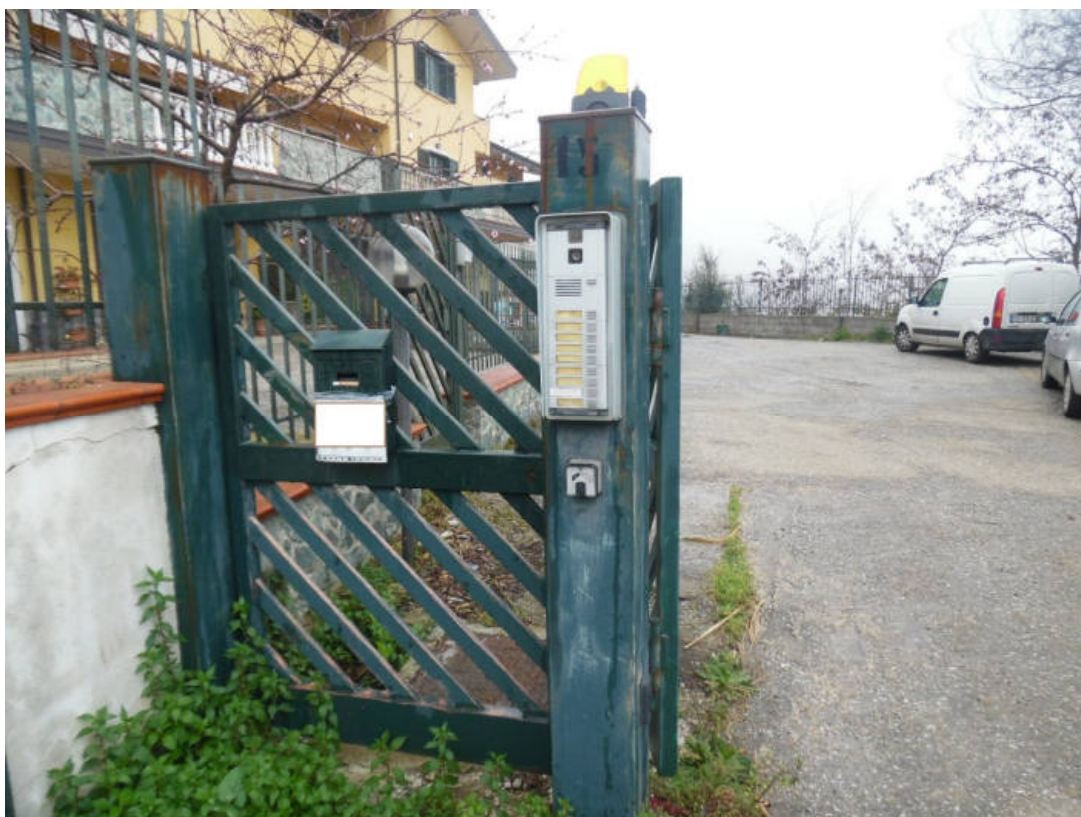
Foto 2: cancello pedonale d'ingresso al fabbricato
