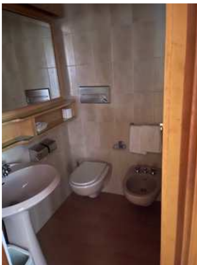
FOTO 15: particolare servizio igienico camera
