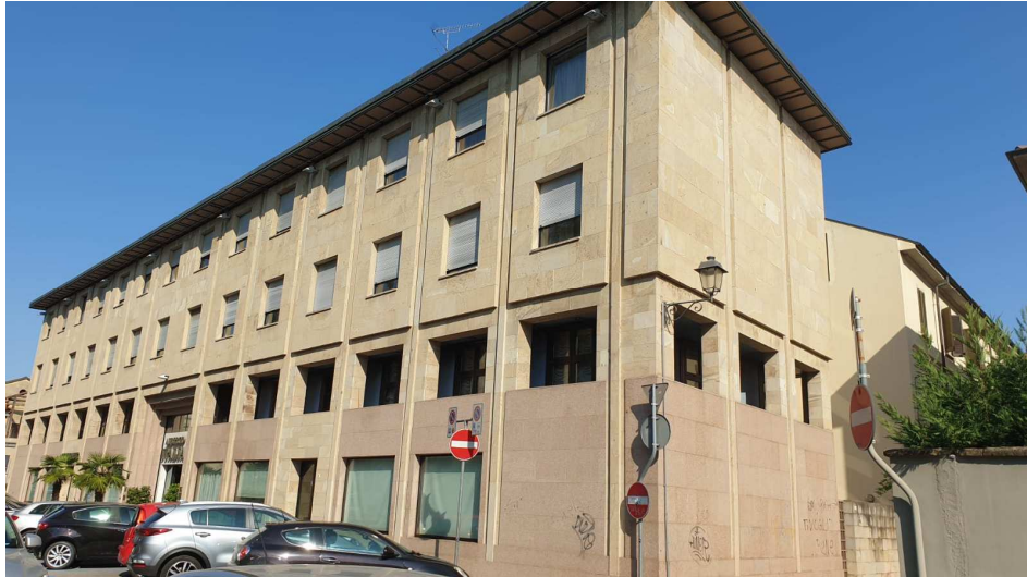
FOTO 1: Prospetto albergo Via Solaroli angolo Via Carotti
