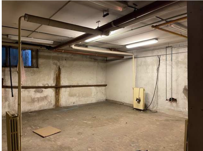
FOTO 21: locali interrati (ex sauna)
