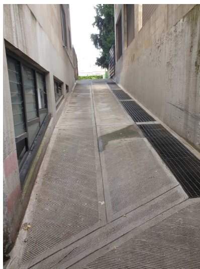
FOTO 18: rampa accesso parcheggio interrato
