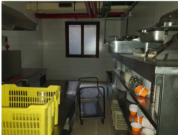
FOTO 22: locali interrati cucina
