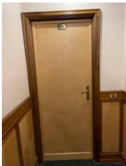
FOTO 13: particolare ingresso camera
