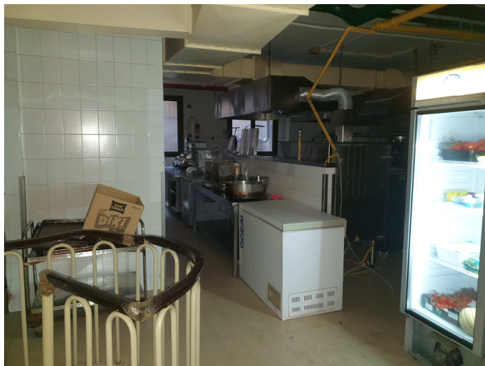
FOTO 23: locali interrati cucina
