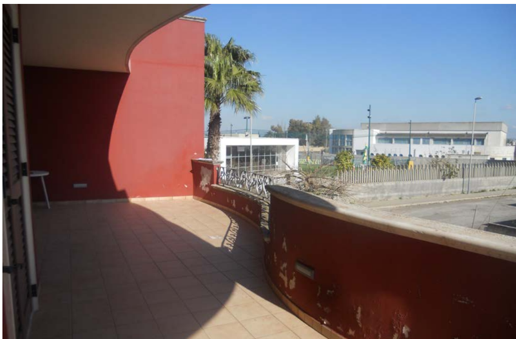
FOTO N6. PARTICOLARE VERANDA PRIMO PIANO
