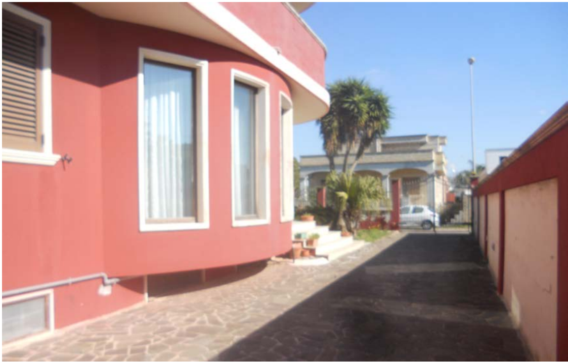
FOTO N.3 PARTICOLARE SCOPERTO DI PERTINENZA
