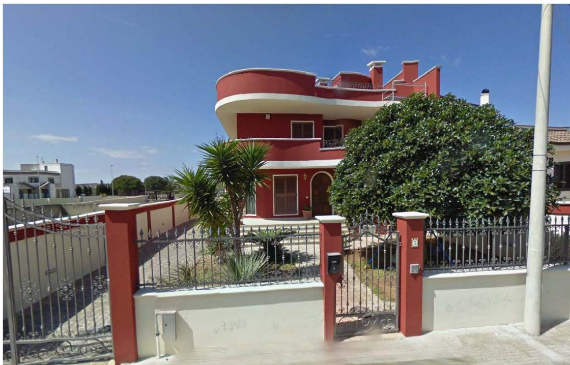
FOTO N.1 PROSPETTO SU VIA FRATELLI ROSSELLI
