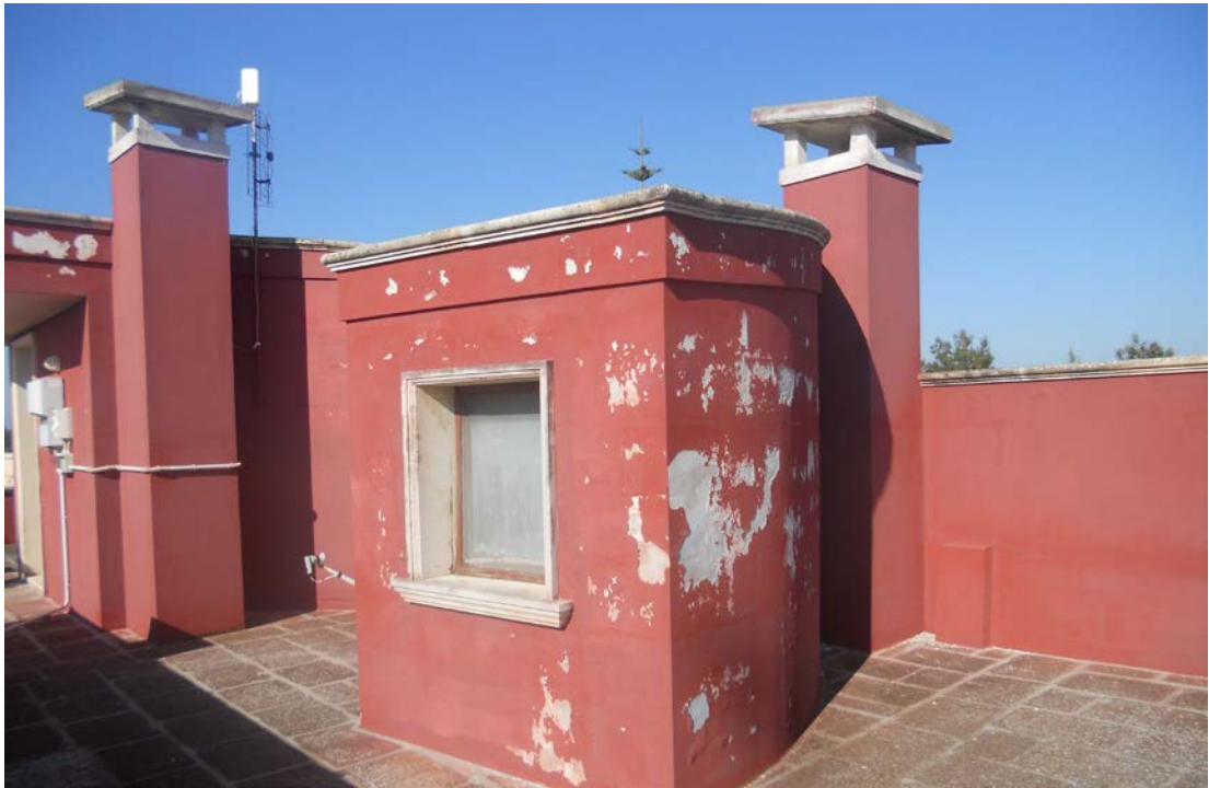
FOTO N.7 PARTICOLARE TORRETTA VANO SCALA
