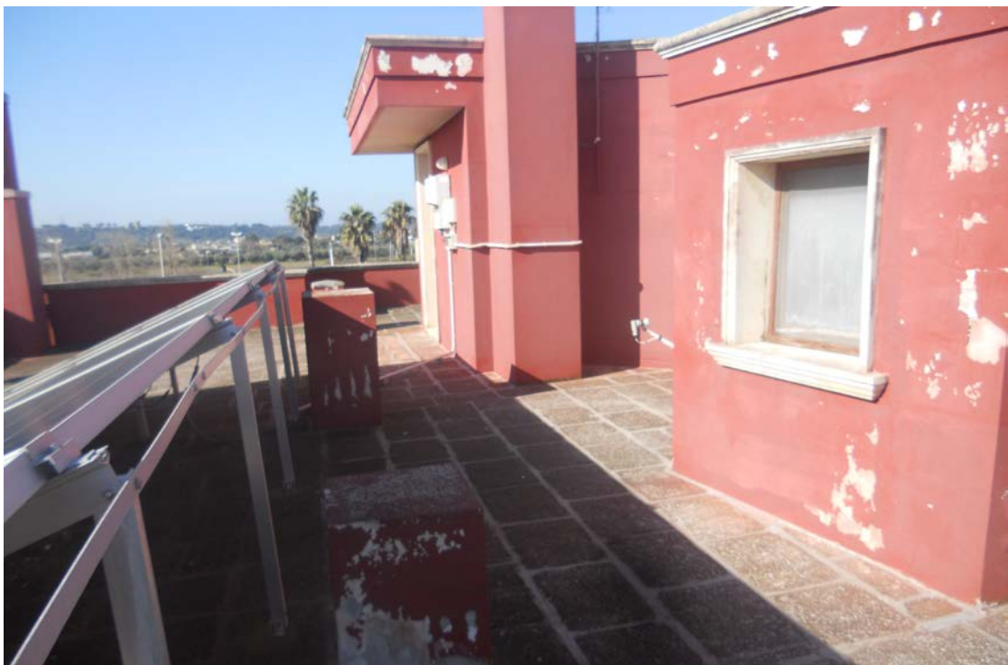
FOTO N.8 PARTICOLARE LASTRICO SOLARE
