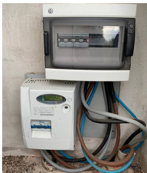
Figura 18: contatore e quadro elettrico
