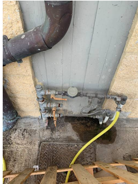
Figura 19: contatore idrico
