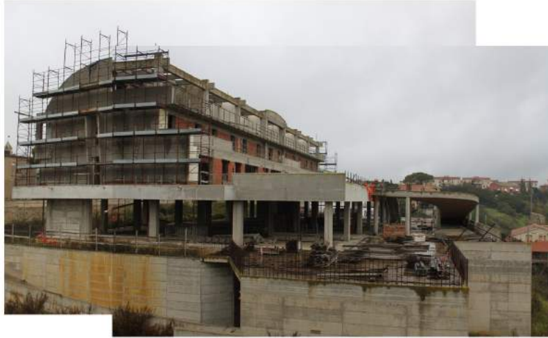
EDIFICIO B FOTO 19
