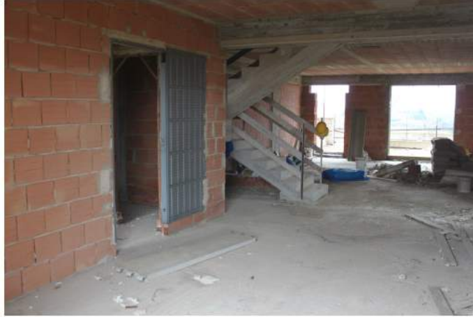
EDIFICIO B FOTO 16
