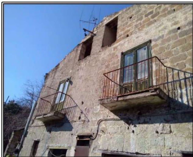
Figura 31 esterno primo piano
