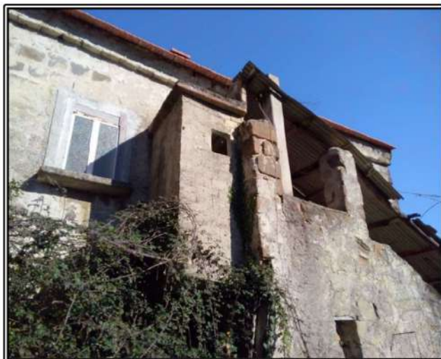
Figura 32 esterno primo piano lato sud
