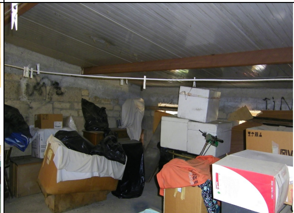
Foto 15 - sottotetto adibito a deposito
