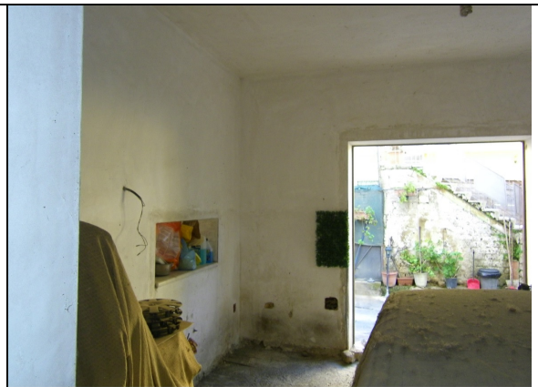
Foto 7 - locale al piano terra adibito a garage
