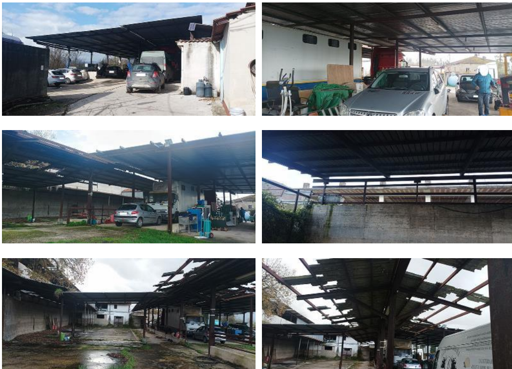
VISTE DELLE TETTOIE LATO OVEST
