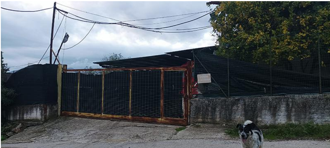
VISTA DELL' ACCESSO AL LOTTO DALLA STRADA
