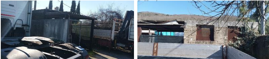
VISTA ESTERNE DA NORD-EST E DA OVEST
