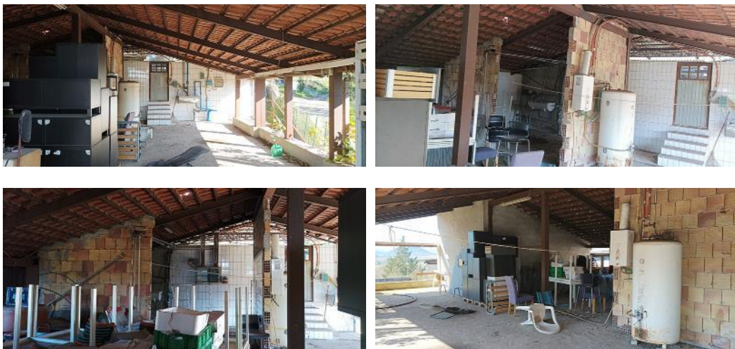
SOTTOTETTO CON OPERE IN CORSO DI REALIZZAZIONE
