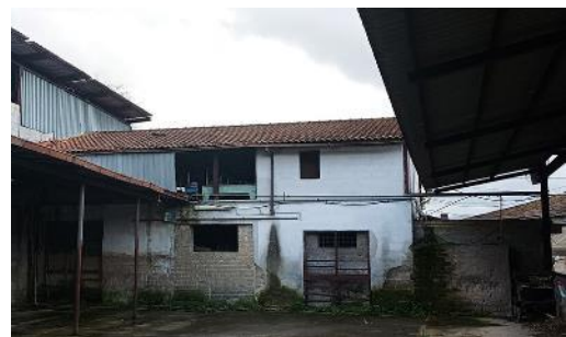
VISTA DA NORD
